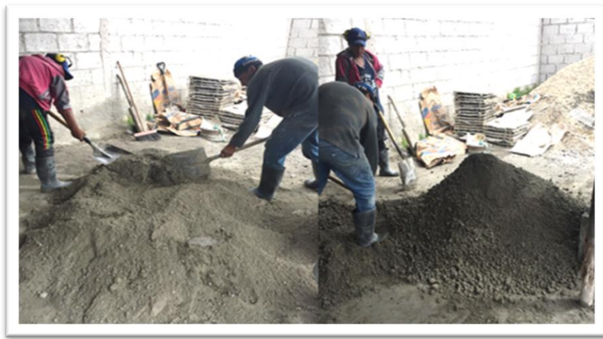
Ilustración 18. Preparación de la mezcla para bloques.
