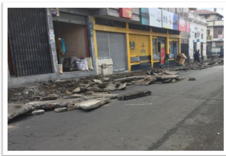
Ilustración 2. Derrocamiento de aceras de las vías principales de la ciudad Riobamba (2017).
