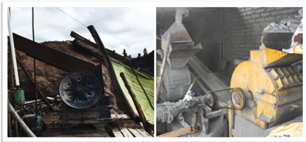
Ilustración 7. Trituradora primaria (der) y secundaria (izq.) de los RCD.
