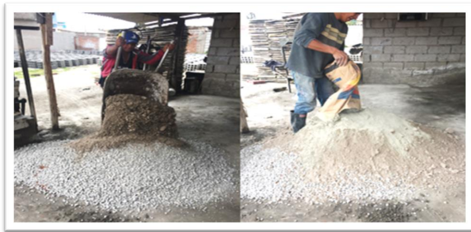
Ilustración 16. Elaboración Mezcla para bloques BMR1.
