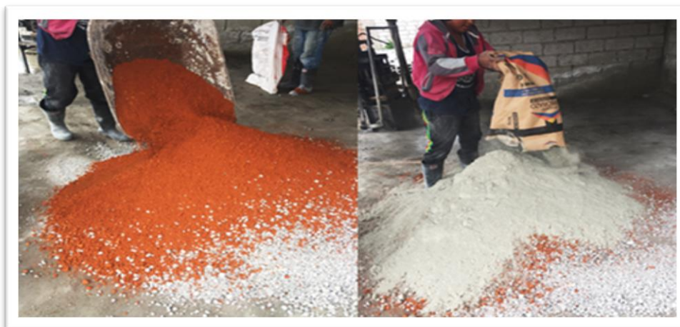
Ilustración 17. Elaboración de la Mezcla para bloques BMR2.
