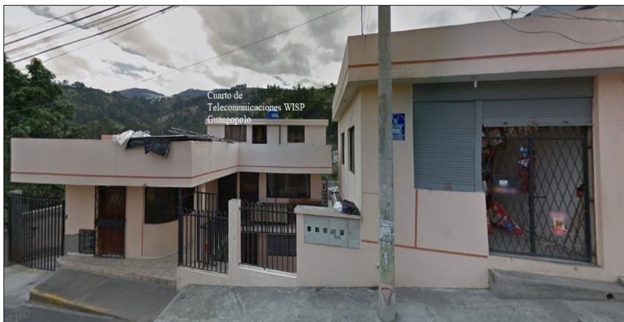
Figura 21. Infraestructura civil designada como nodo principal (Cuarto de telecomunicaciones)
