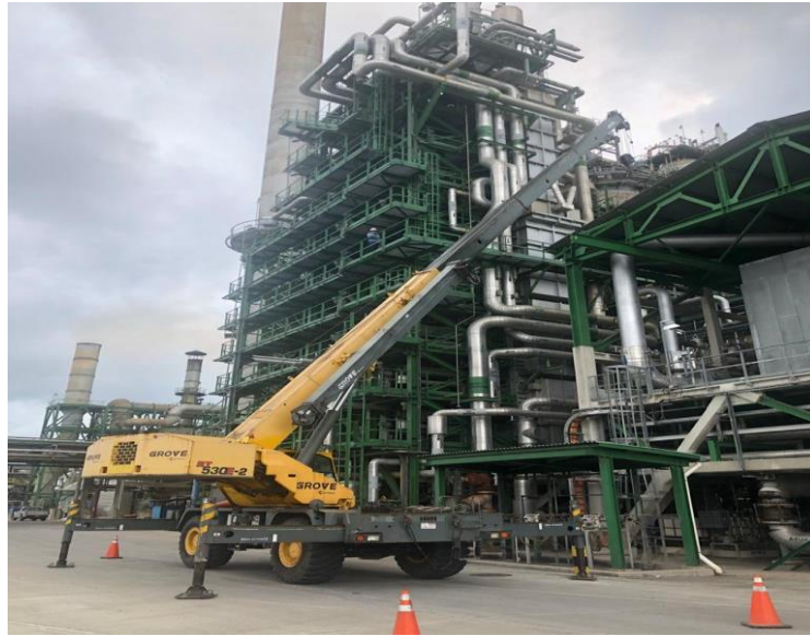
Figura 3 Apoyo a la maniobra de izaje
