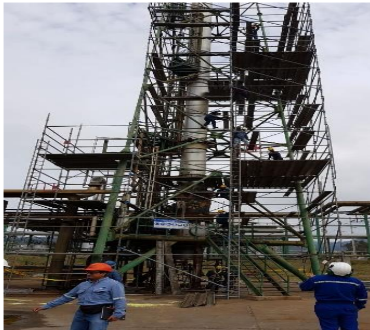
Figura 3 Supervisión de andamiaje
