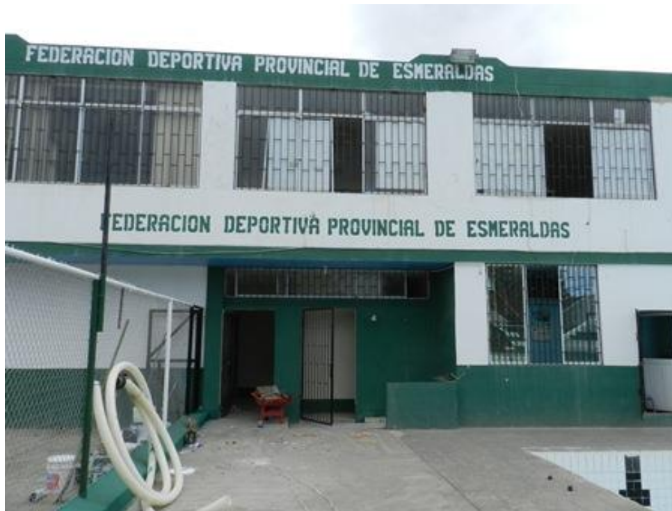
Edificio de la Federación Deportiva de Esmeraldas
