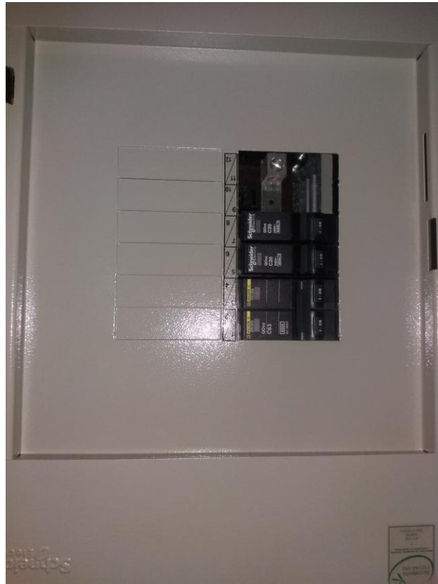
Figura 8. Tablero de transferencia. Autoría propia.
