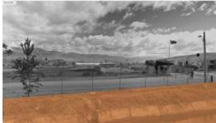
Figura 38: Estado canal de riego Fuente: Google Earth
