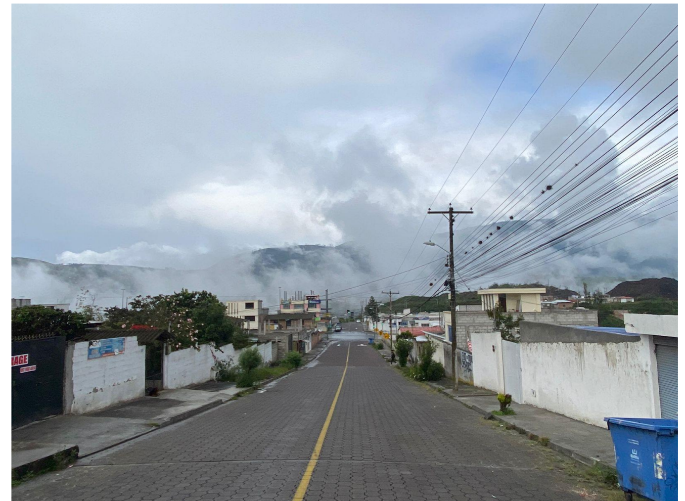
Figura 42 Estado de aceras y calzadas
