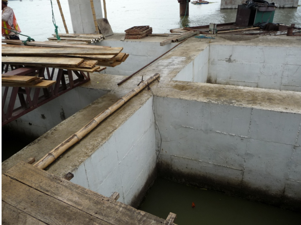
SISTEMA VIGA-ZAPATA CONCLUIDO
