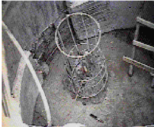
Encepado de un pilote fundido In situ
