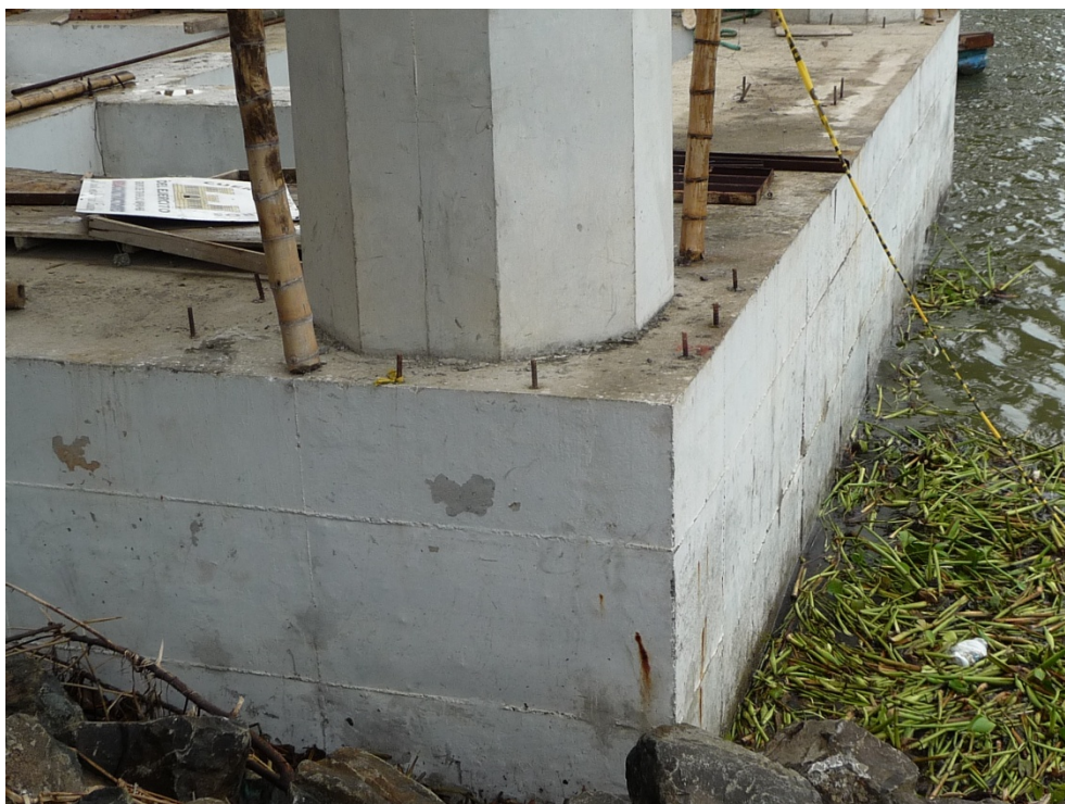
SISTEMA VIGA-ZAPATA CONCLUIDO
