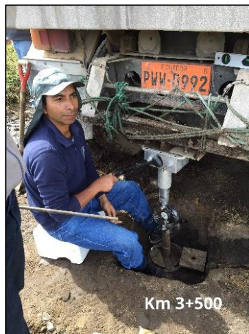
Foto 3.64. Realización del ensayo CBR in-situ
