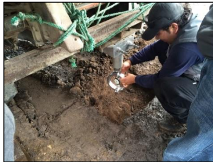
Foto 3.58. Colocación del anillo de carga
