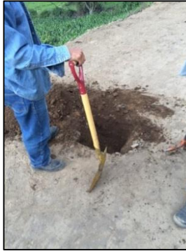
Foto 3.53. Excavación de la calicata
