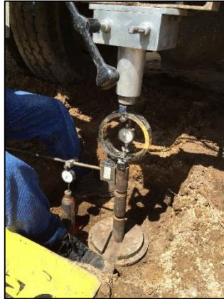
Foto 3.62. Ubicación del deformímetro
