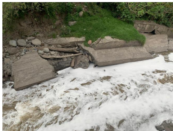
Fotografía 11: paredes de concreto para intentar un nuevo trazado en el río. Fuente: Cevallos, A. (2019), El Machángara, en la vía láctea, Cumbayá.
