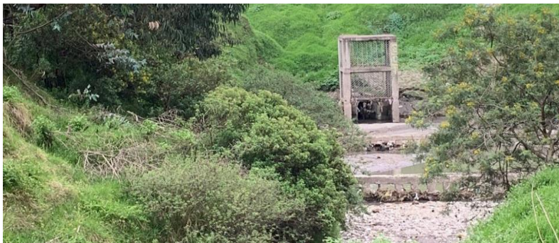
Fotografía 9: Implementación del programa de descontaminación de los ríos de Quito, sistema de mallas con graderío implementado para el cribado. Fuente: Cevallos, A. (2019) El Machángara en la quebrada de Shanshayacu
