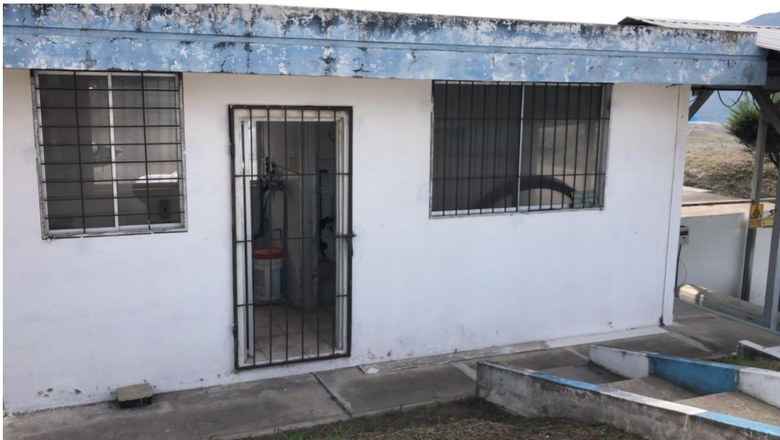
Fotografía 9: Cuarto de cloración de la planta de Azaya
