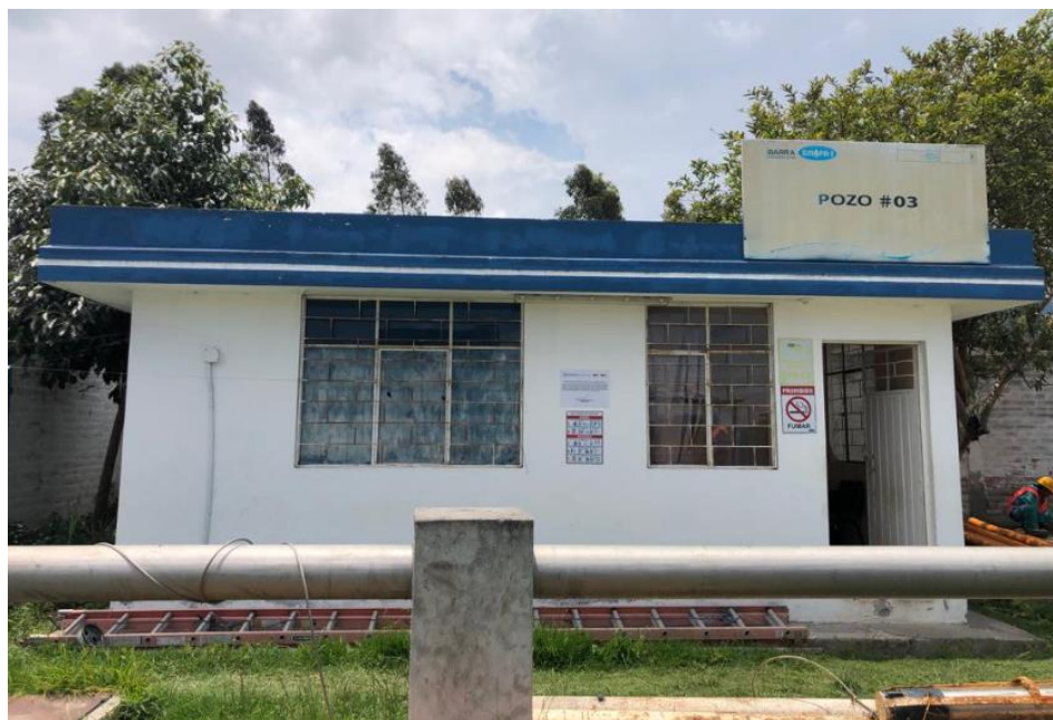
Fotografía 7: Fuente de abastecimiento - Pozo #3 Yuyucocha
