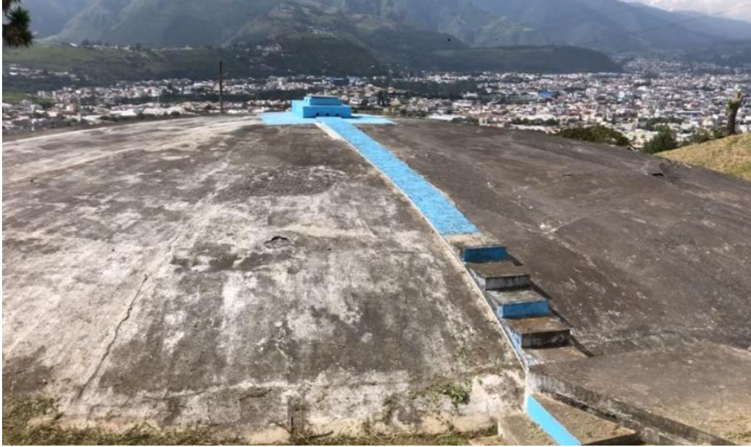
Fotografía 10: Cubierta del tanque de Azaya
