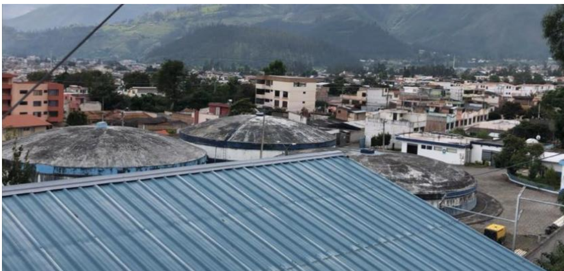
Fotografía 3: Tanques de almacenamiento de Caranqui
