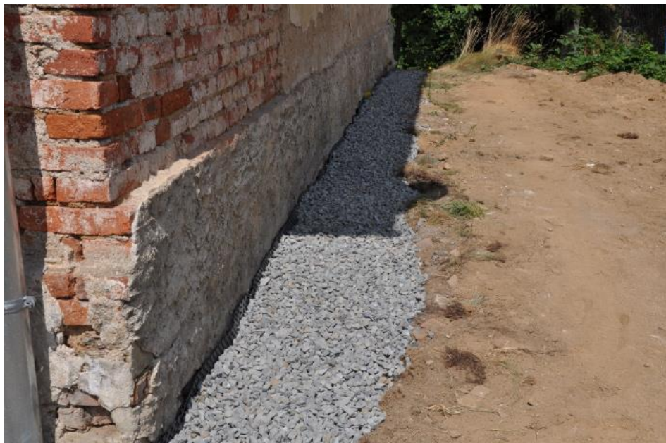
Ilustración 4.38 Relleno de la zanja con ripio triturado (Dytiga, 2014)
