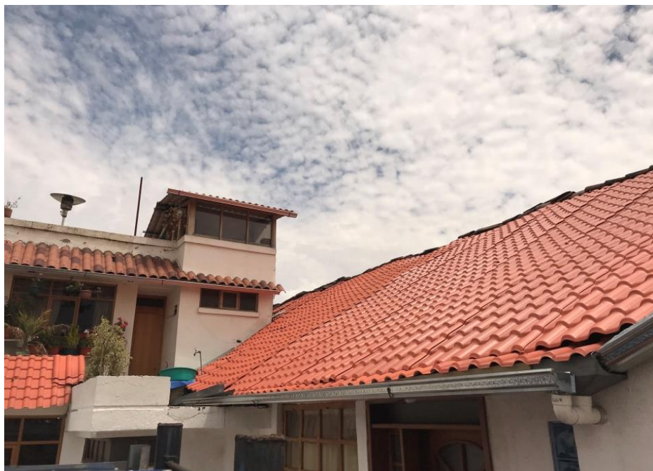
Ilustración 2.52 Cubierta de eternit tipo teja (Elaboración propia, 2019)
