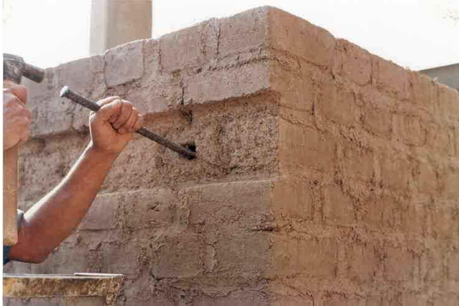
Ilustración 4.52 Perforaciones para colocar los conectores (CERESIS, 2015)
