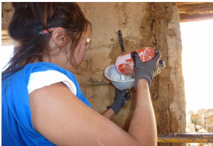
Ilustración 4.21 Inyección de la lechada con embudo (Constructor, 2014)
