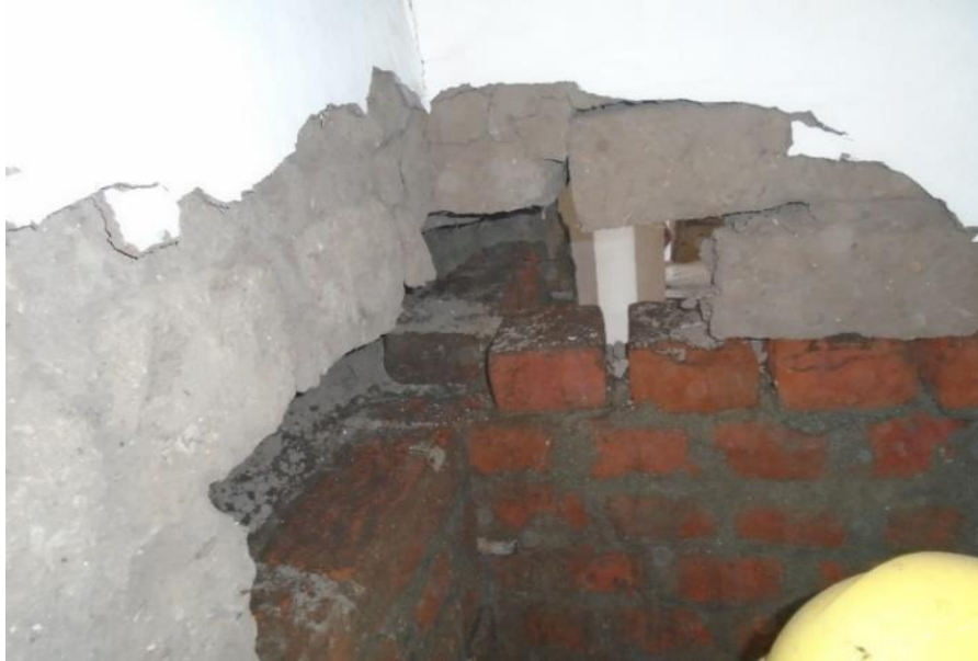
Ilustración 2.34 Cosido y descosido de los ladrillos (DocPlayer, 2016)
