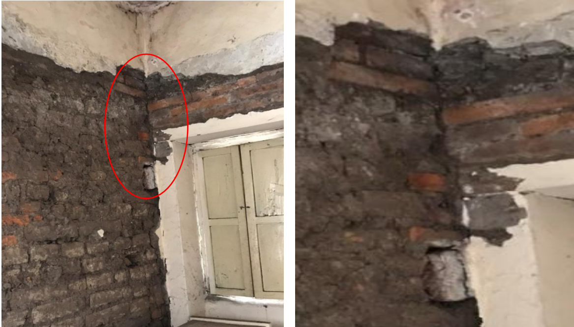
Ilustración 3.29 Separación de las mampostería en la casa 2 (Elaboración propia, 2019)
