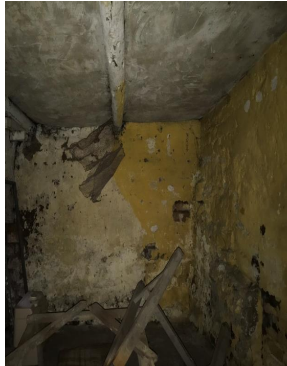
Ilustración 3.58 Descascaramientos y eflorcencias en muros de adobe en la casa 3 (Elaboración propia, 2019)
