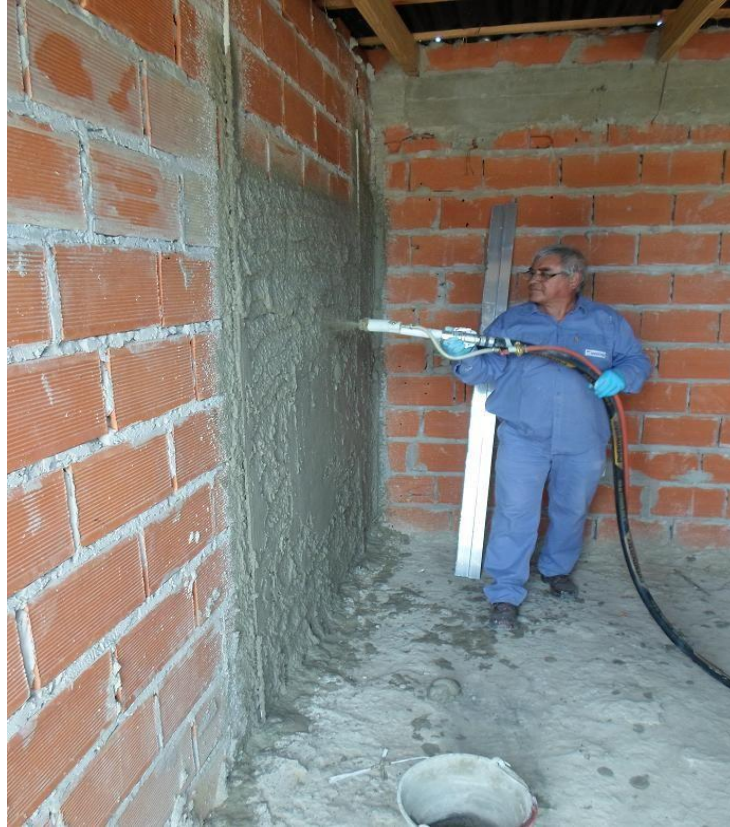
Ilustración 4.31 Enlucido con cemento en muro de ladrillo (Reformaster, 2016)
