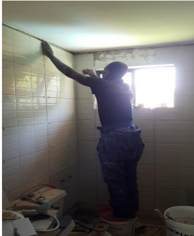
Ilustración 4.3 Colocación de porcelanato (Eldia, 2016)
