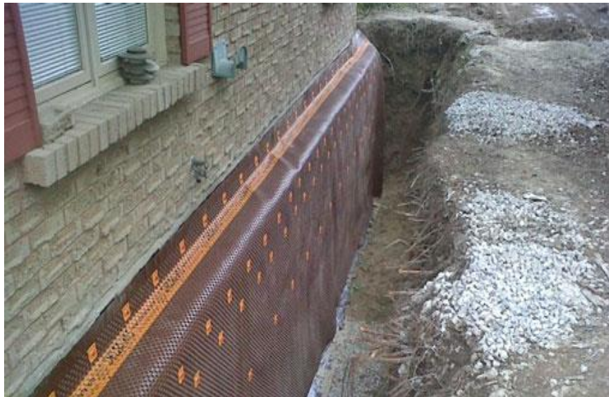
Ilustración 2.51 Protección con una lámina nodular de polietileno (López y Pacheco SL, 2017)
