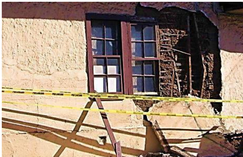
Ilustración 2.40 Incompatibilidad de materiales (ResearchGate, 2013)
