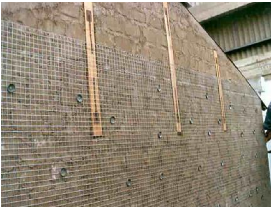
Ilustración 4.54 Clavado de la malla tipo gallinero (CERESIS, 2015)
