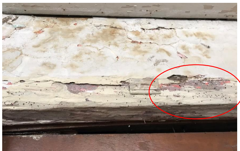
Ilustración 3.33 Carcomas en un dintel de madera en la casa 3 (Elaboración propia, 2019)
