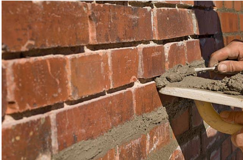
Ilustración 2.25 Relleno de las juntas con mortero (Trabver, 2010)
