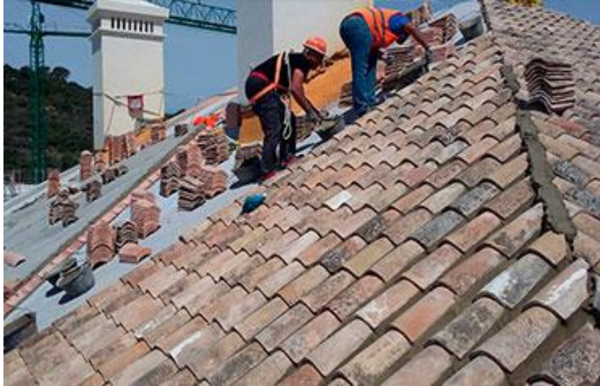
Ilustración 4.50 Colocación de tejas coloniales (Proceram, 2017)
