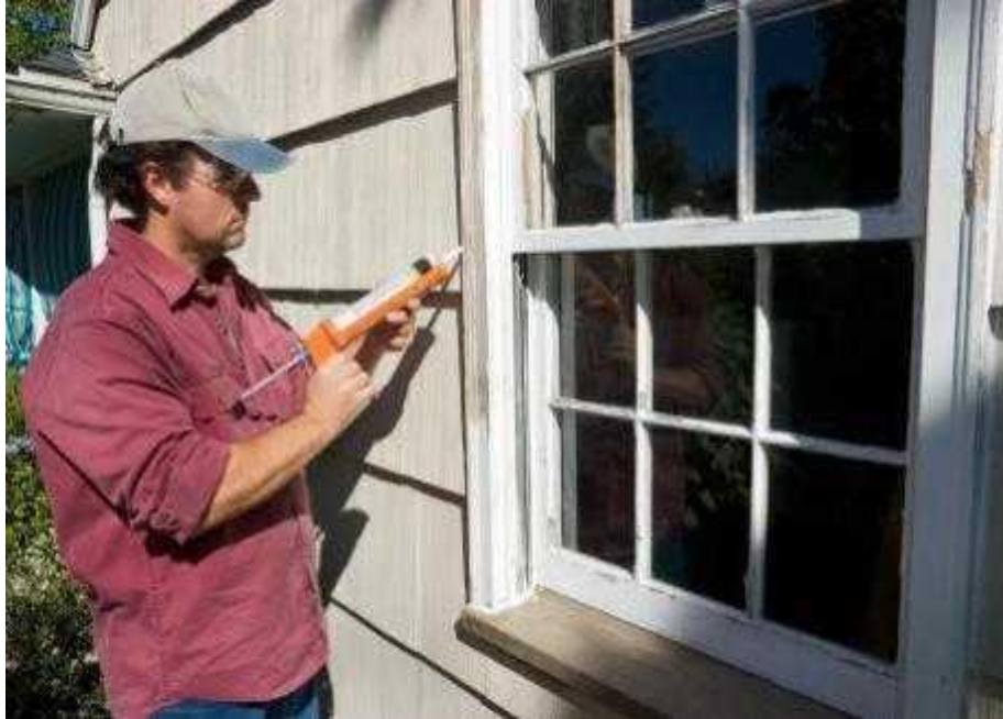
Ilustración 4.59 Sellamiento de ventanas con un producto elastómero (Bioguía, 2014)
