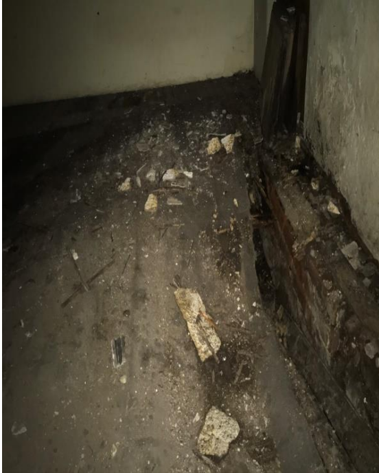
Ilustración 3.49 Daño en tumbado de carrizo y en el piso de madera en la casa 3 (Elaboración propia, 2019)
