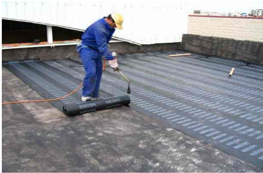
Ilustración 2.53 Impermeabilización de una losa con chova (DOPLIM, 2019)
