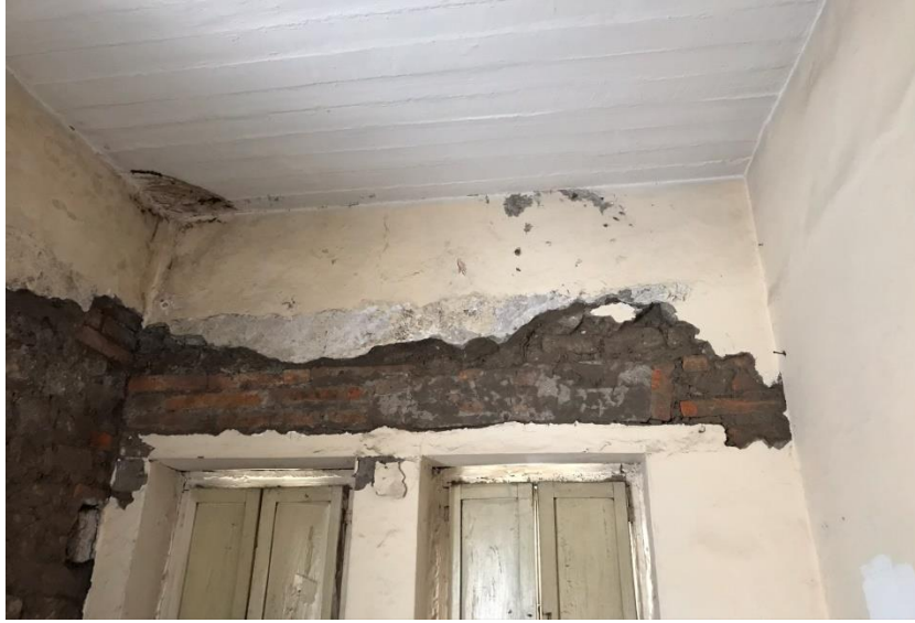
Ilustración 2.41 Incompatibilidad de materiales (Elaboración propia, 2019)
