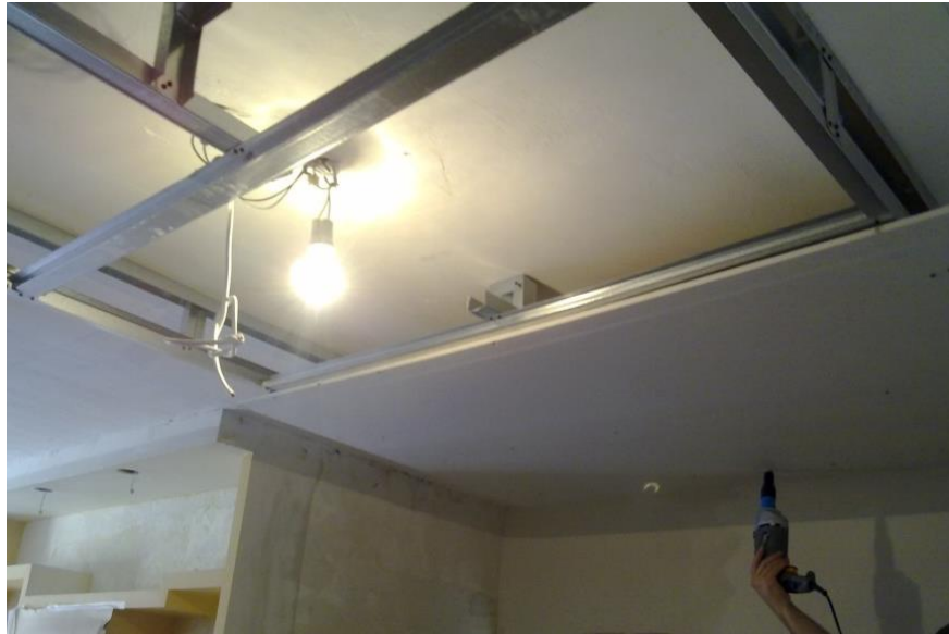
Ilustración 4.55 Instalación de un tumbado de gypsum (SICON, 2018)
