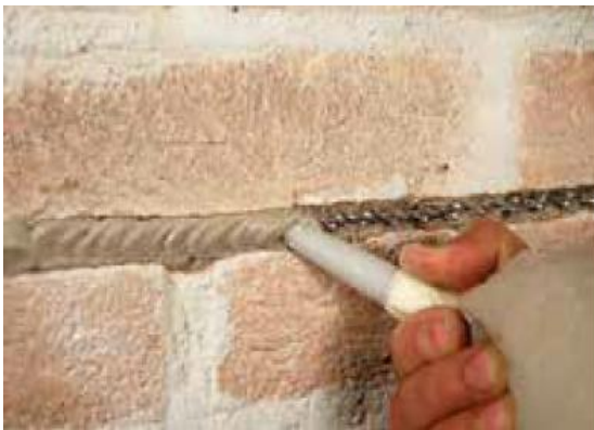
Ilustración 2.24 Sellado de la junta con mortero (Kerakoll, 2015)
