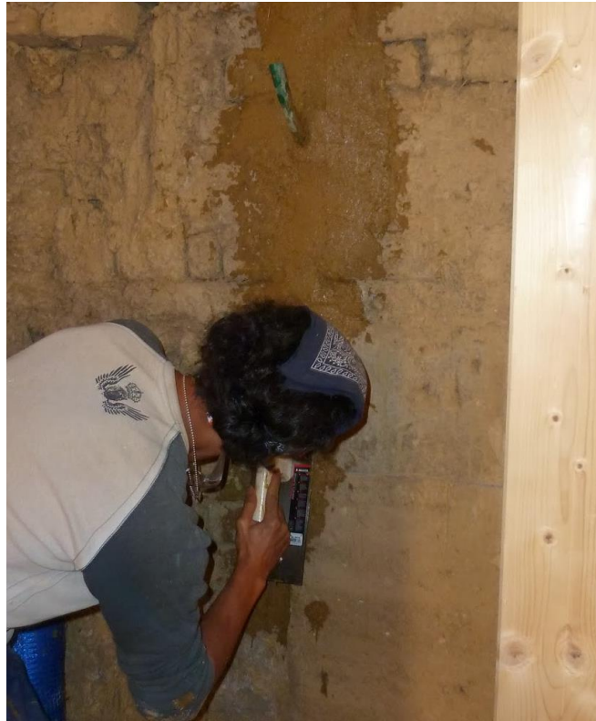
Ilustración 4.20 Sellado de la junta con mortero (Constructor, 2014)
