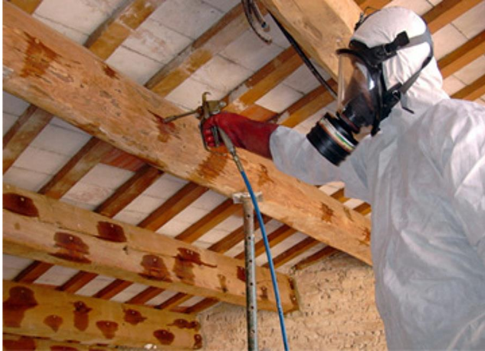
Ilustración 4.34 Inyección en para erradicar insectos (Massim, 2017)
