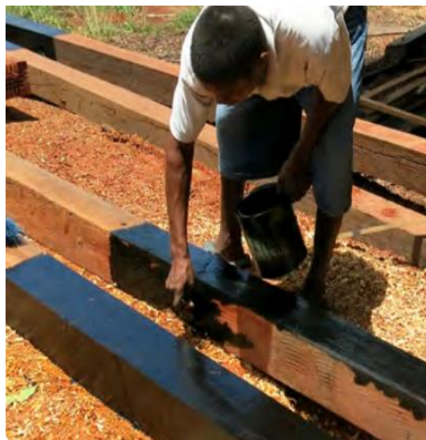
Ilustración 4.10 Tratamiento de la madera con diesel (COPECO, 2013)
