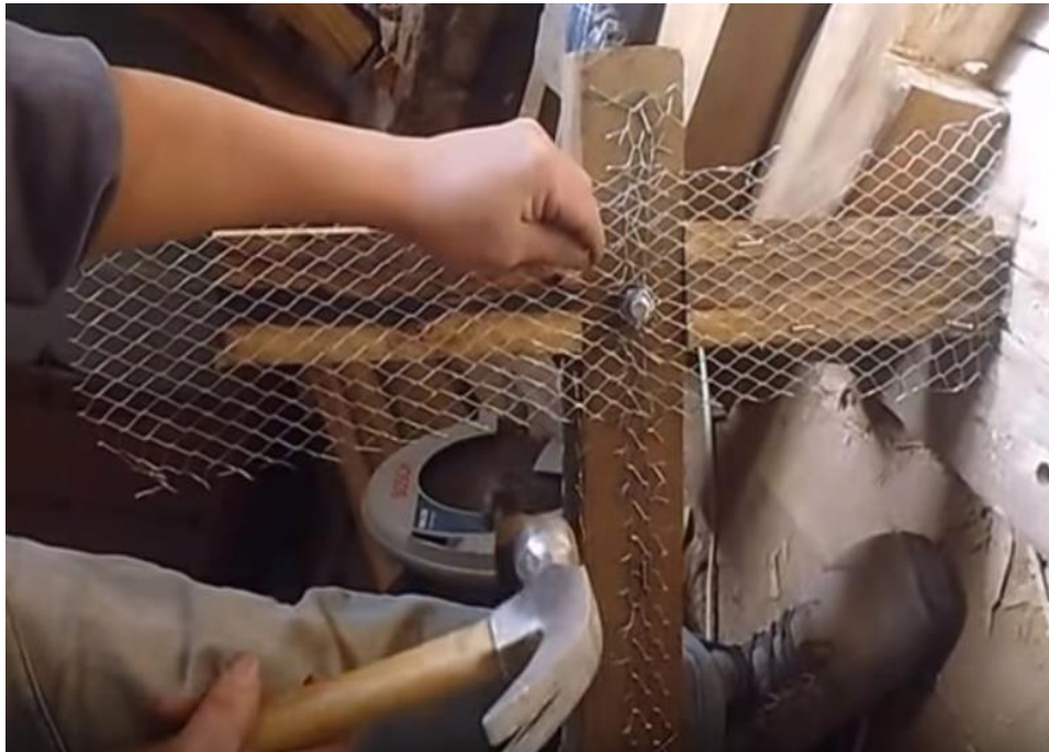
Ilustración 4.26 Colocación de la malla de gallinero en la llave de madera (Ebasl, 2014)
