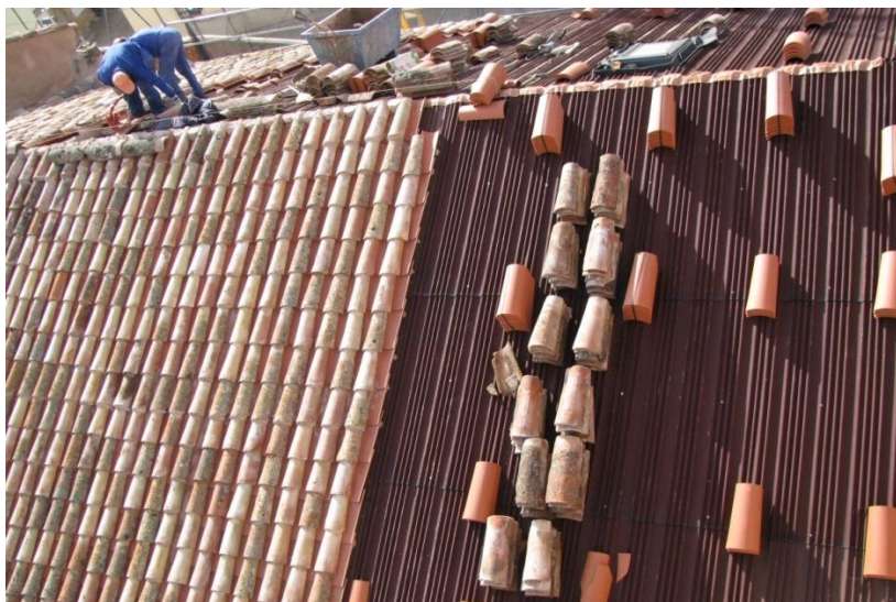
Ilustración 2.27 Fijación de tejas coloniales en una cubierta (Proceram, 2016)
