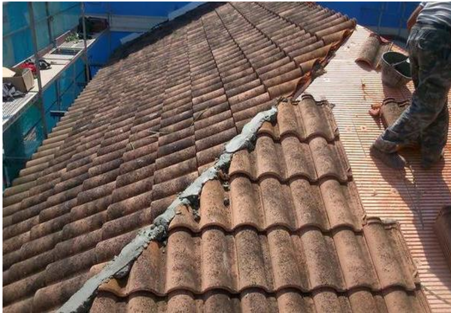
Ilustración 4.48 Colocación de tejas coloniales (Slideshare, 2018)
