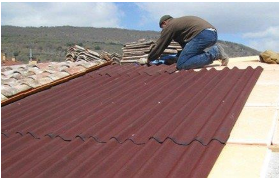
Ilustración 4.45 Colocación de placas asfálticas onduladas (Onduline, 2019)
