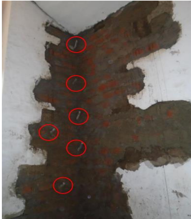
Ilustración 4.57 Inyección de lechada mediante manguerillas (Trabajo de Titulación en la UDLA, 2017)
