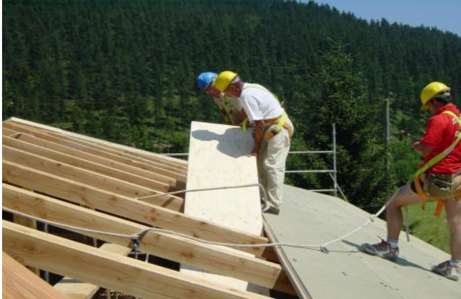
Ilustración 4.44 Instalación de tableros de aglomerado hidrófugo en una cubierta (Onduline, 2019)
