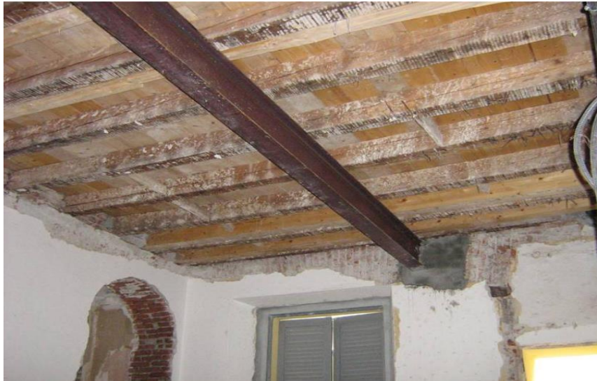
Ilustración 2.32 Reforzamiento del piso con un tubo metálico (Reotec, 2017)
