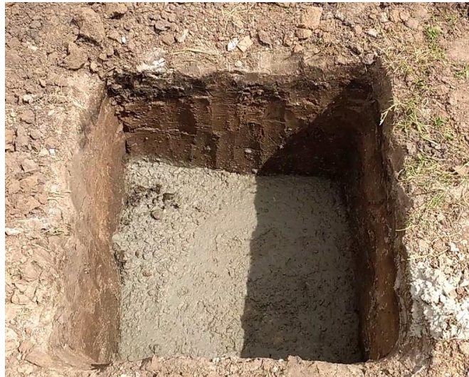
Ilustración 4.9 Excavación y fundición del replantillo (Slideshare, 2008)
