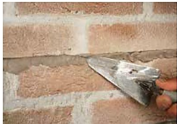
Ilustración 2.24 Sellado de la junta con mortero (Kerakoll, 2015)
