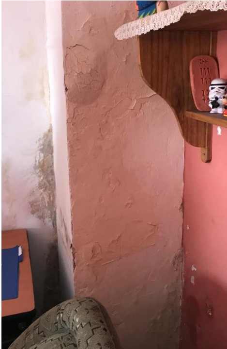
Ilustración 3.37 Descascaramientos en mampostería de adobe en la casa 1 (Elaboración propia, 2019)
