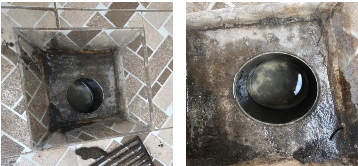
Ilustración 3.18 Desagüe de agua lluvia en la casa 4 (Elaboración propia, 2019)
