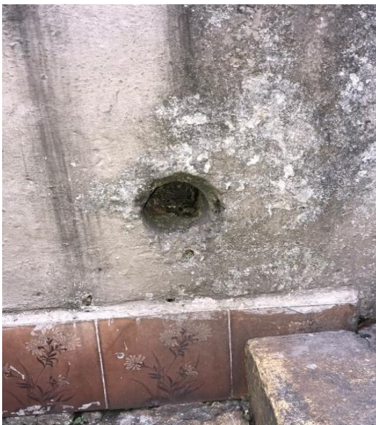
Ilustración 3.60 Obstrucción de un mechinal por falta de mantenimiento en la casa 3 (Elaboración propia, 2019)
