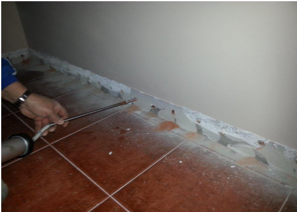
Ilustración 4.40 Inyección química basada en resinas en un muro (HumelIngeniería, 2016)
