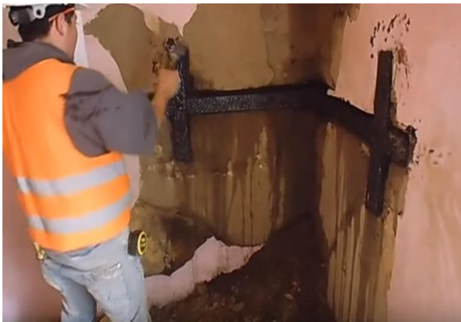
Ilustración 4.28 Colocación de la llave de madera (Ebasl, 2014)
