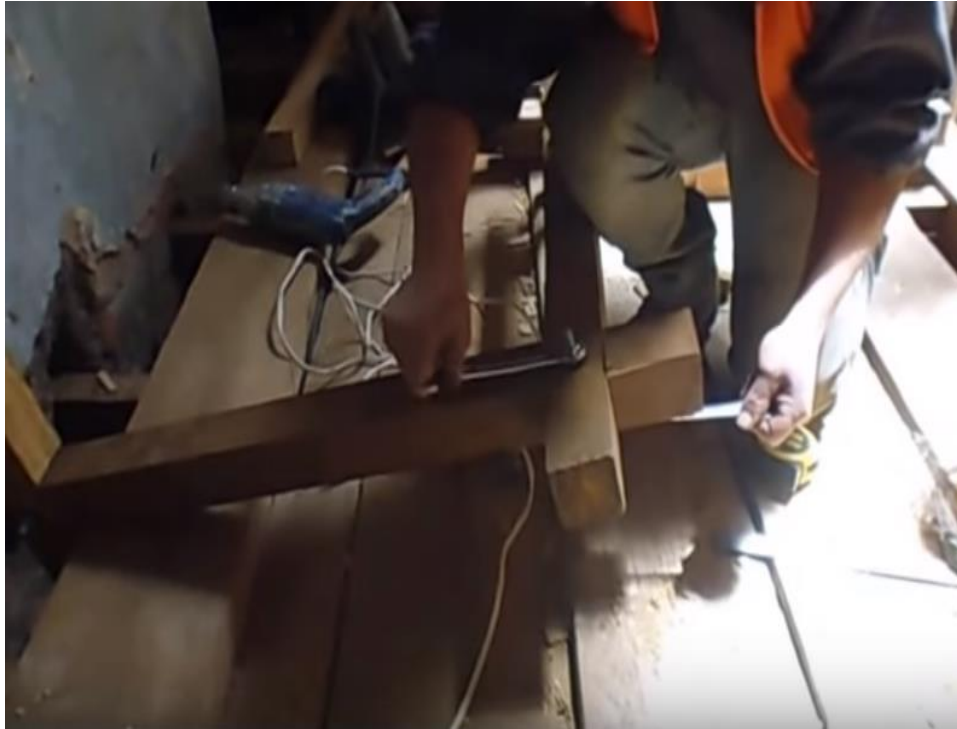
Ilustración 4.25 Ajuste de las varillas enroscadas (Ebasl, 2014)
