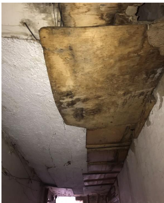
Ilustración 3.48 Daño en tumbado de carrizo en la casa 3 (Elaboración propia, 2019)
