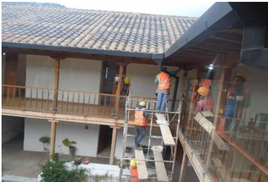
Ilustración 4.51 Reparación de canales de aguas lluvia (Trabajo de Titulación en la UDLA, 2017)
