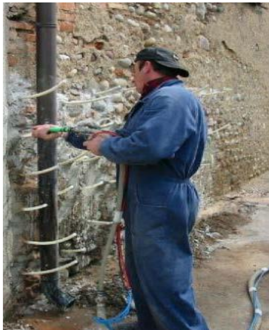
Ilustración 2.33 Inyección de lechada mediante medios mecánicos (Reotec, 2017)
