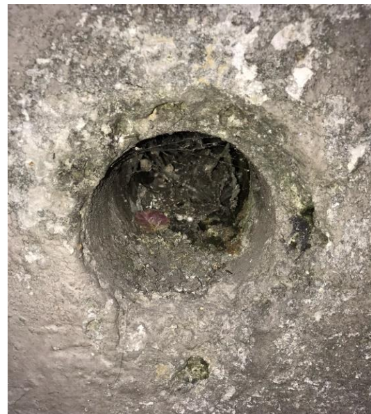
Ilustración 3.60 Obstrucción de un mechinal por falta de mantenimiento en la casa 3 (Elaboración propia, 2019)
