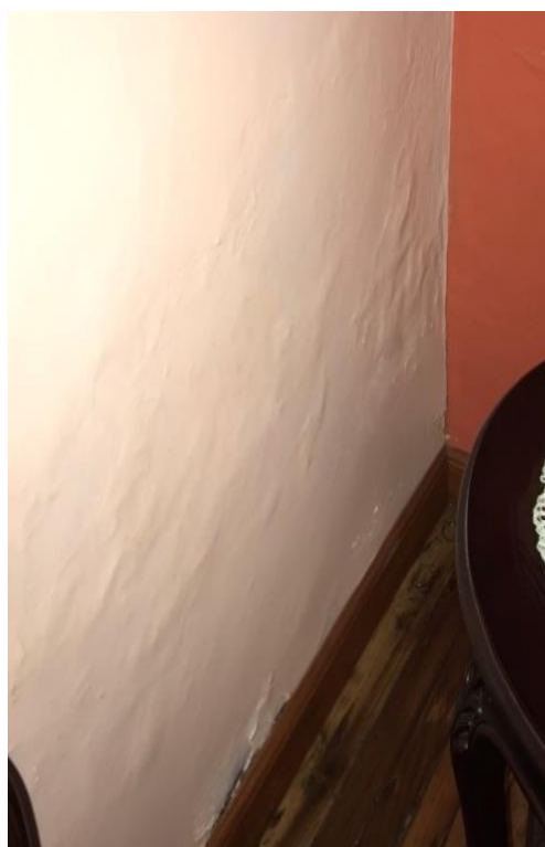
Ilustración 3.40 Descascaramientos en mampostería de adobe en la casa 4 (Elaboración propia, 2019)
