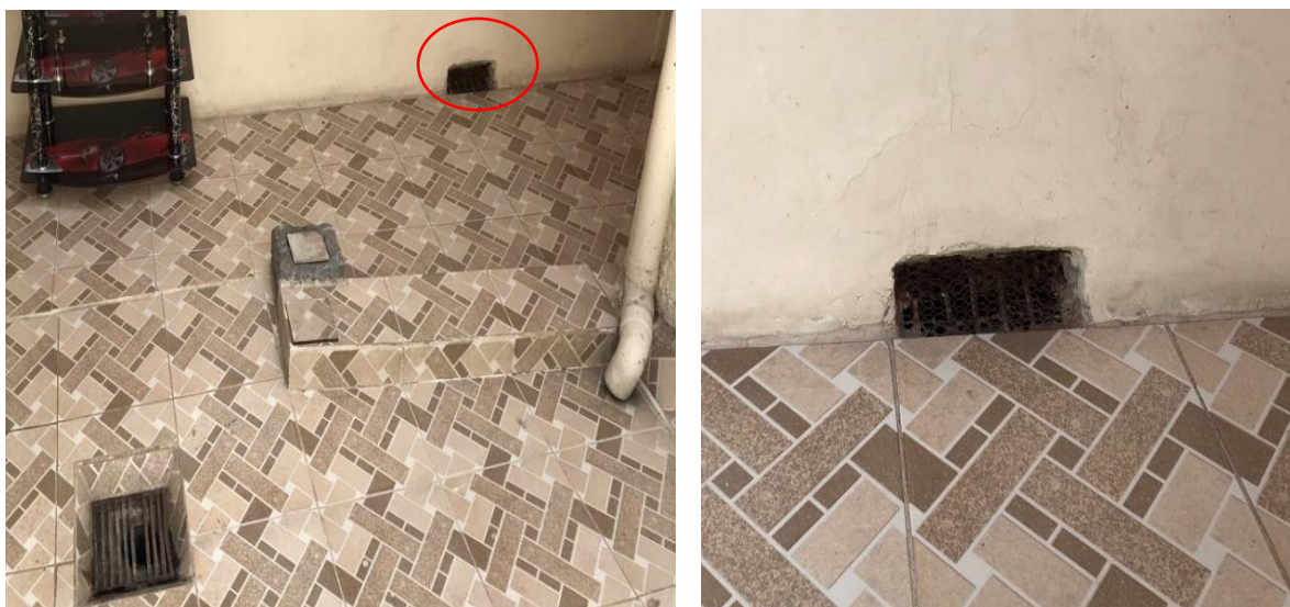
Ilustración 3.22 Mechinal en la casa 4 (Elaboración propia, 2019)
