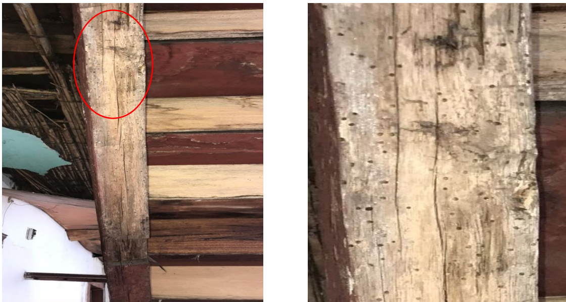
Ilustración 3.32 Carcomas en elemento de madera en la casa 2 (Elaboración propia, 2019)
