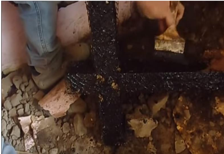
Ilustración 4.27 Impermeabilizante en la llave de madera (Ebasl, 2014)
