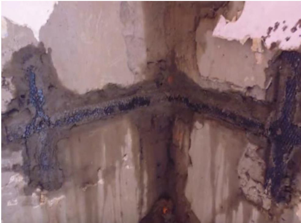
Ilustración 4.30 Colocación del mortero a base de cal (Ebasl, 2014)
