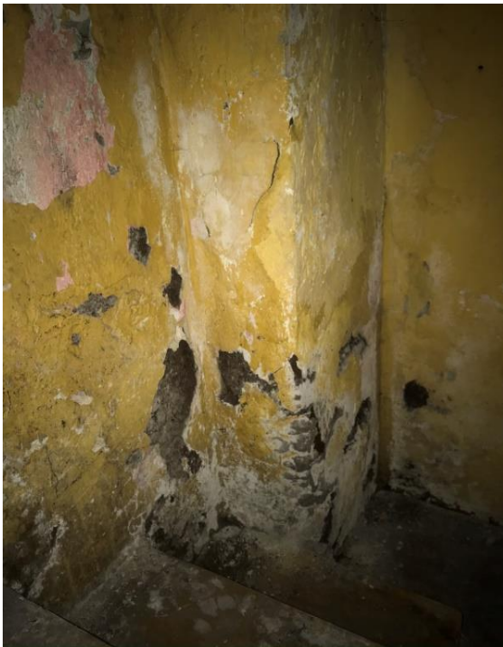
Ilustración 3.58 Descascaramientos y eflorcencias en muros de adobe en la casa 3 (Elaboración propia, 2019)
