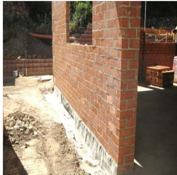
Ilustración 2.49 Barrera impermeable (Unión Europea, 2017)
