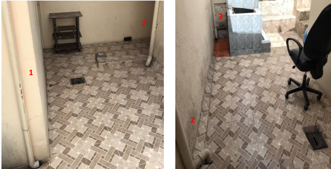
Ilustración 3.19 Bajantes de agua lluvia en la casa 4 (Elaboración propia, 2019)
