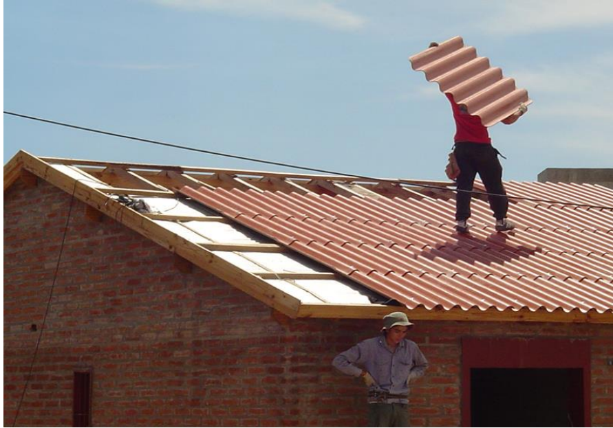
Ilustración 4.46 Colocación de planchas de eternit (Eternit, 2017)
