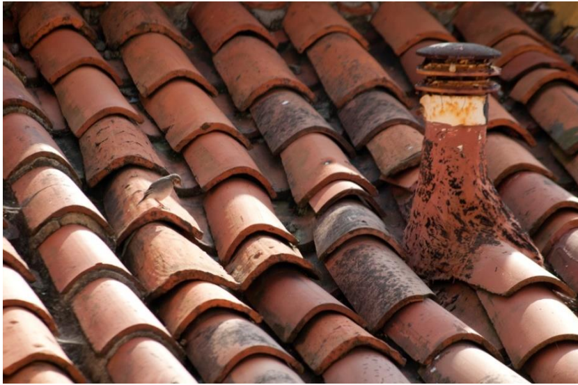
Ilustración 2.16 Tejas movidas en una cubierta (Promart, 2018)
