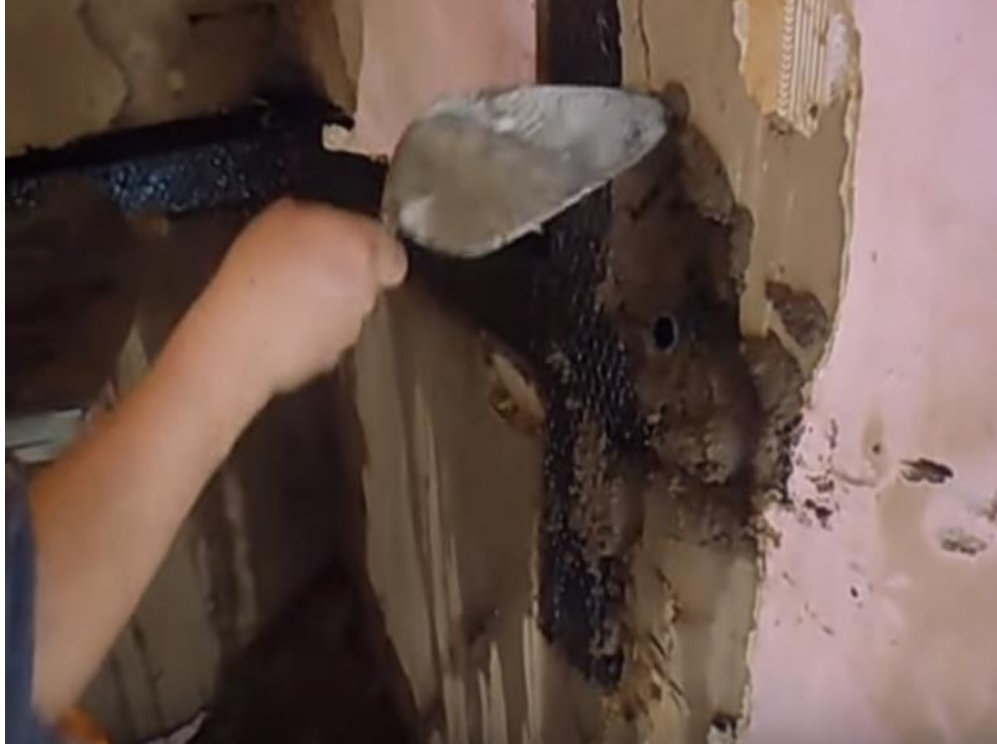
Ilustración 4.29 Colocación del mortero a base de cal (Ebasl, 2014)
