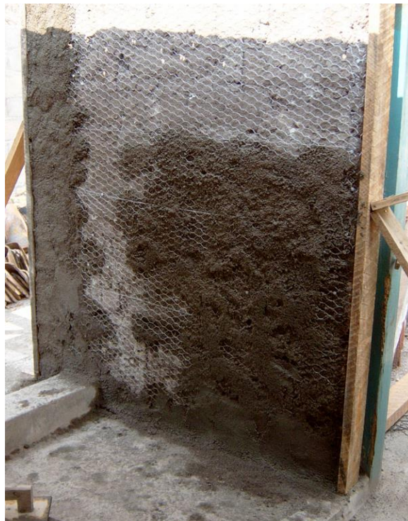
Ilustración 2.54 Malla de gallinero en un muro de adobe (Slideshare, 2014)
