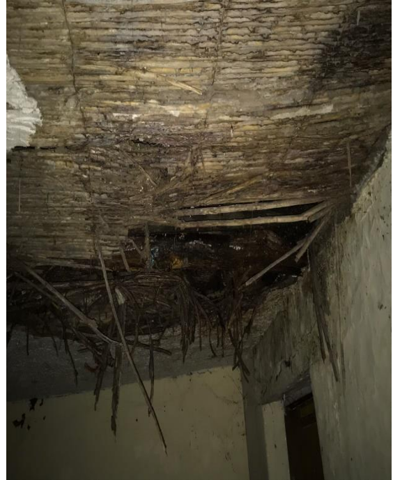
Ilustración 3.49 Daño en tumbado de carrizo y en el piso de madera en la casa 3 (Elaboración propia, 2019)
