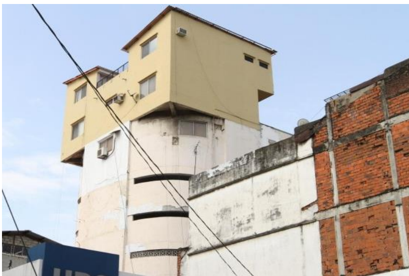
Ilustración 2.28 Construcción de un nivel adicional (Expreso, 2017)
