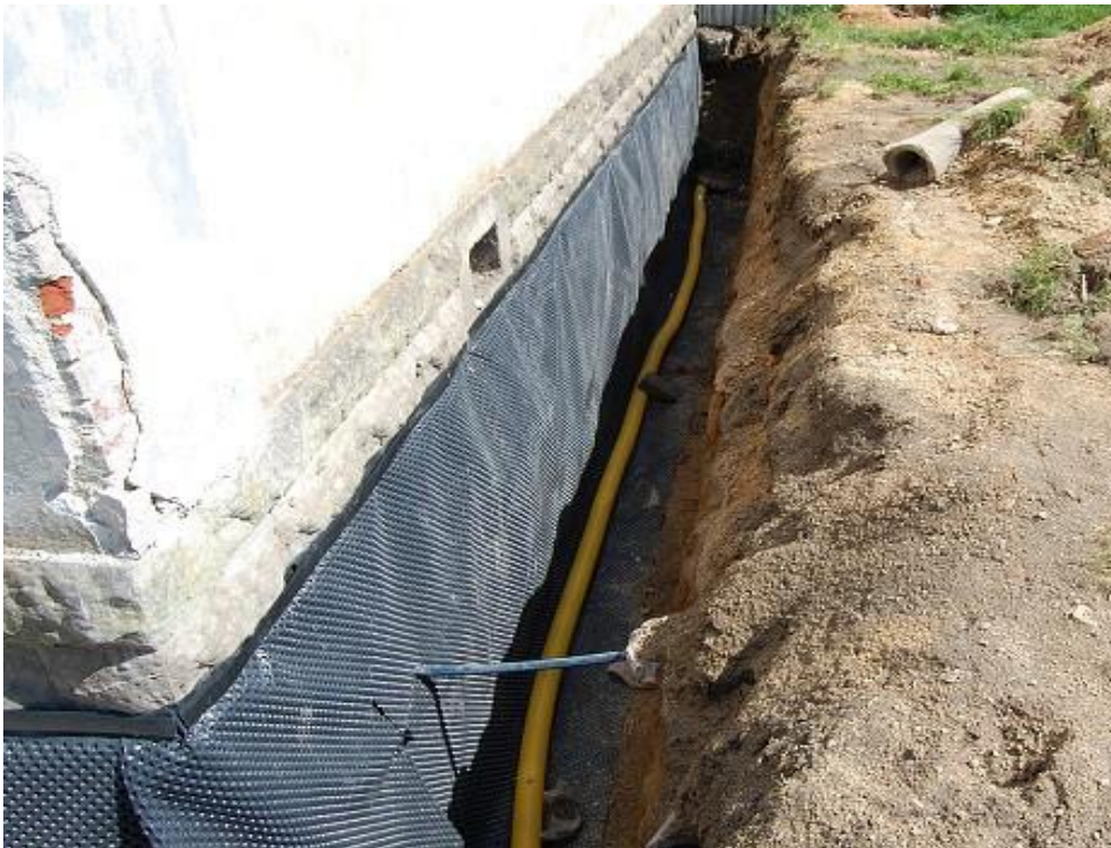
Ilustración 4.36 Colocación de tubos perforados (Vojtanov, 2017)
