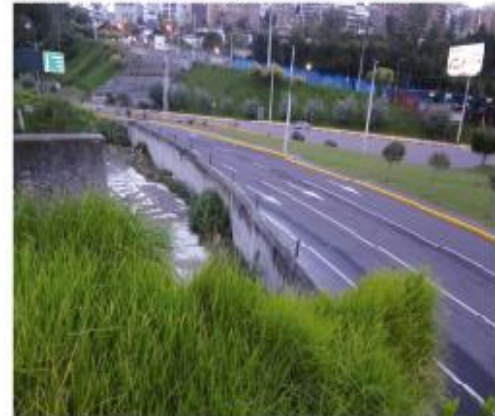
Vista a la Av. Interoceánica.
