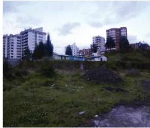
Vista desde el terreno a límite sur-oeste. Dificil acceso a CENTRO DE DESARROLLO INFANTIL MANUELA CAÑIZARES.
