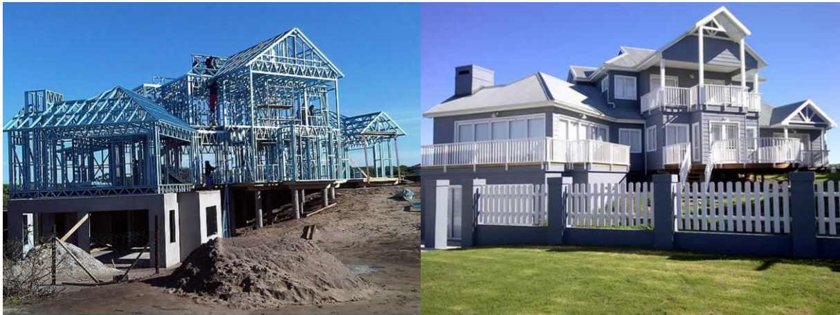
Ilustración 5: Vivienda residencial. Fuente: http://www.frametech.co.za/example_projects
