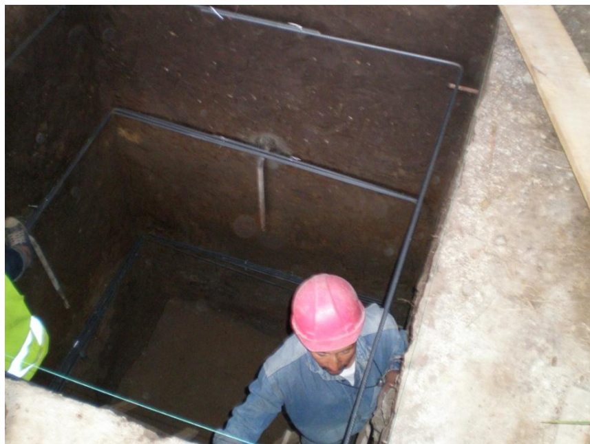
Imagen 3.12. Anclajes fundidos.
