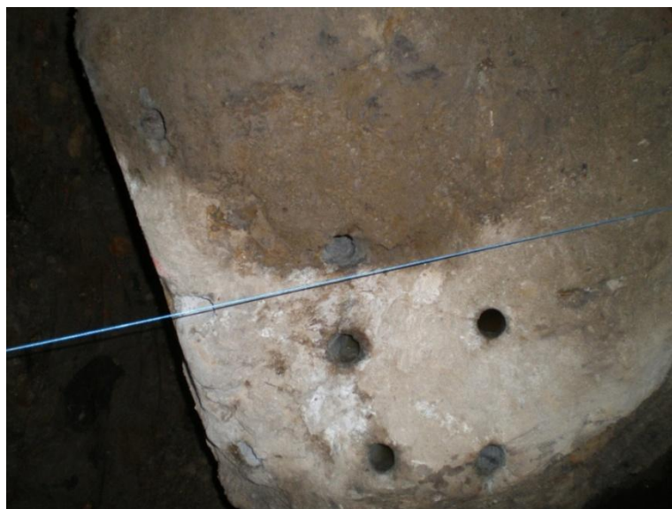
Imagen 3.19. Roca taladrada para colocar explosivos.
