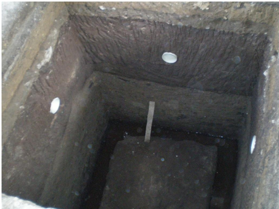
Imagen 3.6. Pozo con excavación para anclajes.
