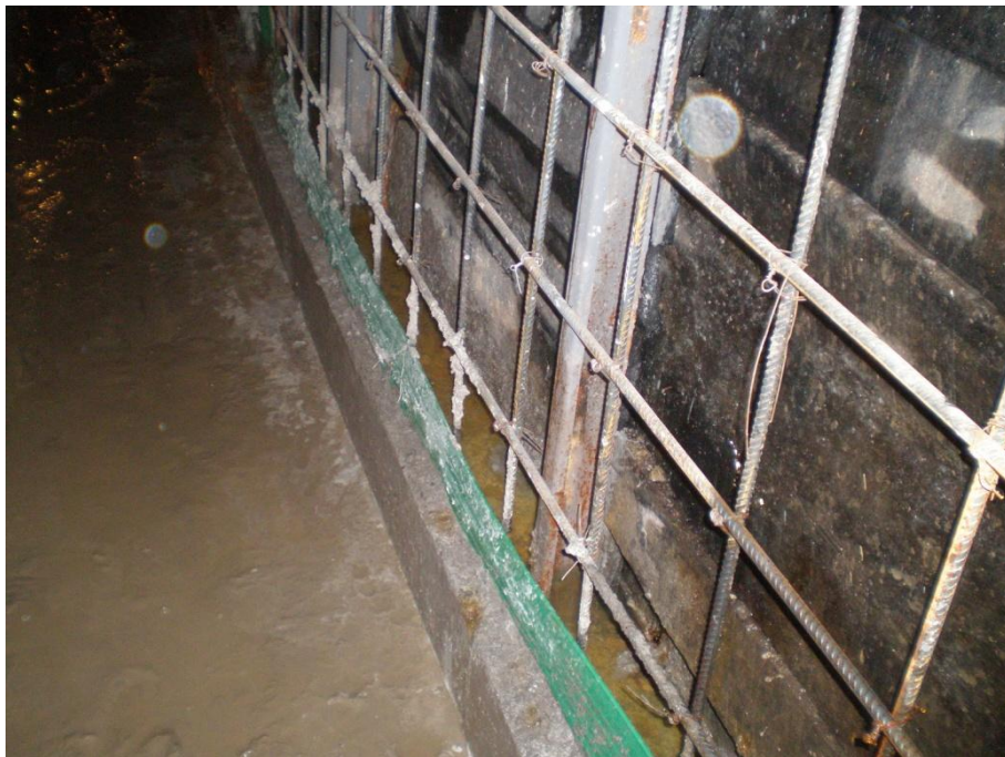
Imagen 3.35. Arranque de muro.
