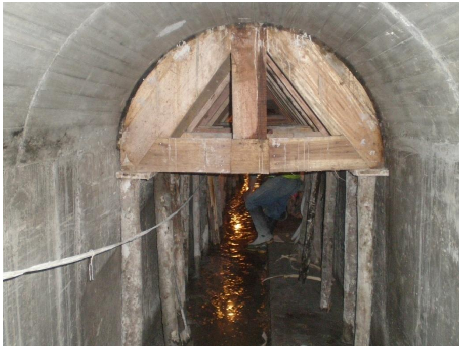
Imagen 3.37. Encofrados de bóveda.
