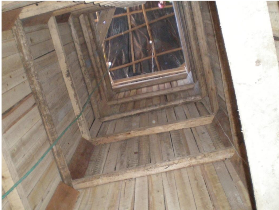
Imagen 3.23. Pozo completamente entibado. Vista inferior.
