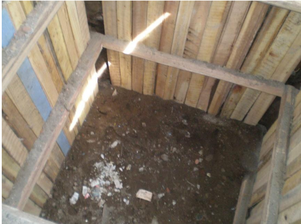
Imagen 3.10. Colocación de entibados.
