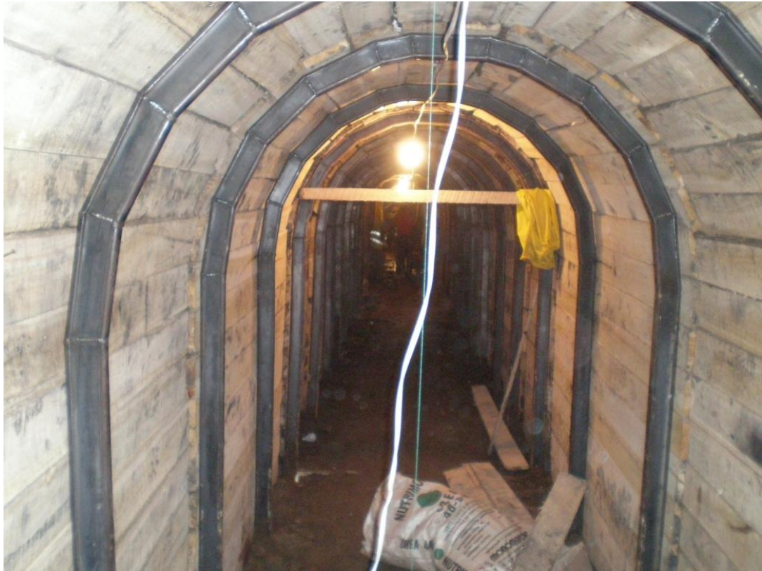
Imagen 3.29. Cerchas metálicas con entibado permanente de madera.
