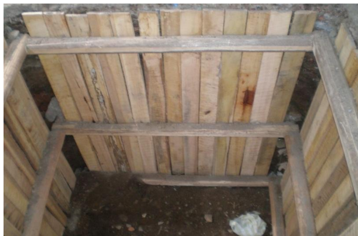
Imagen 3.24. Colocación de marcos de madera y de tablones.
