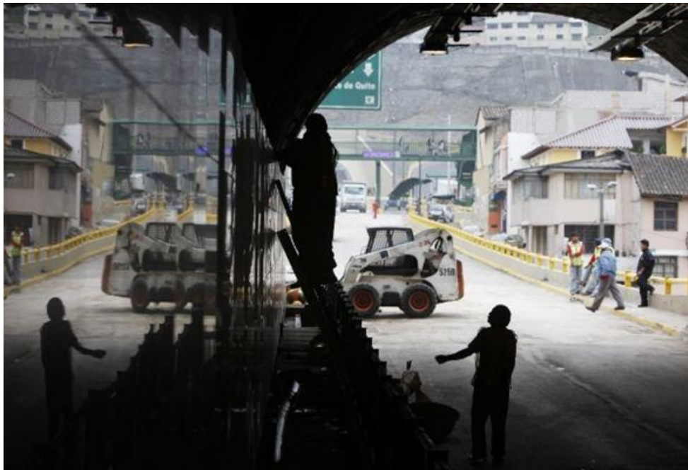
Imagen 1.2. Túnel de San Diego-Quito. Colocación de pavimento Rígido. 5
