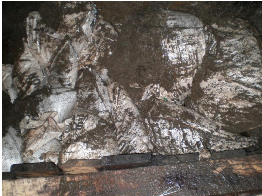
Imagen 3.33. Colocación de saquillos sobre los marcos tipo galería.
