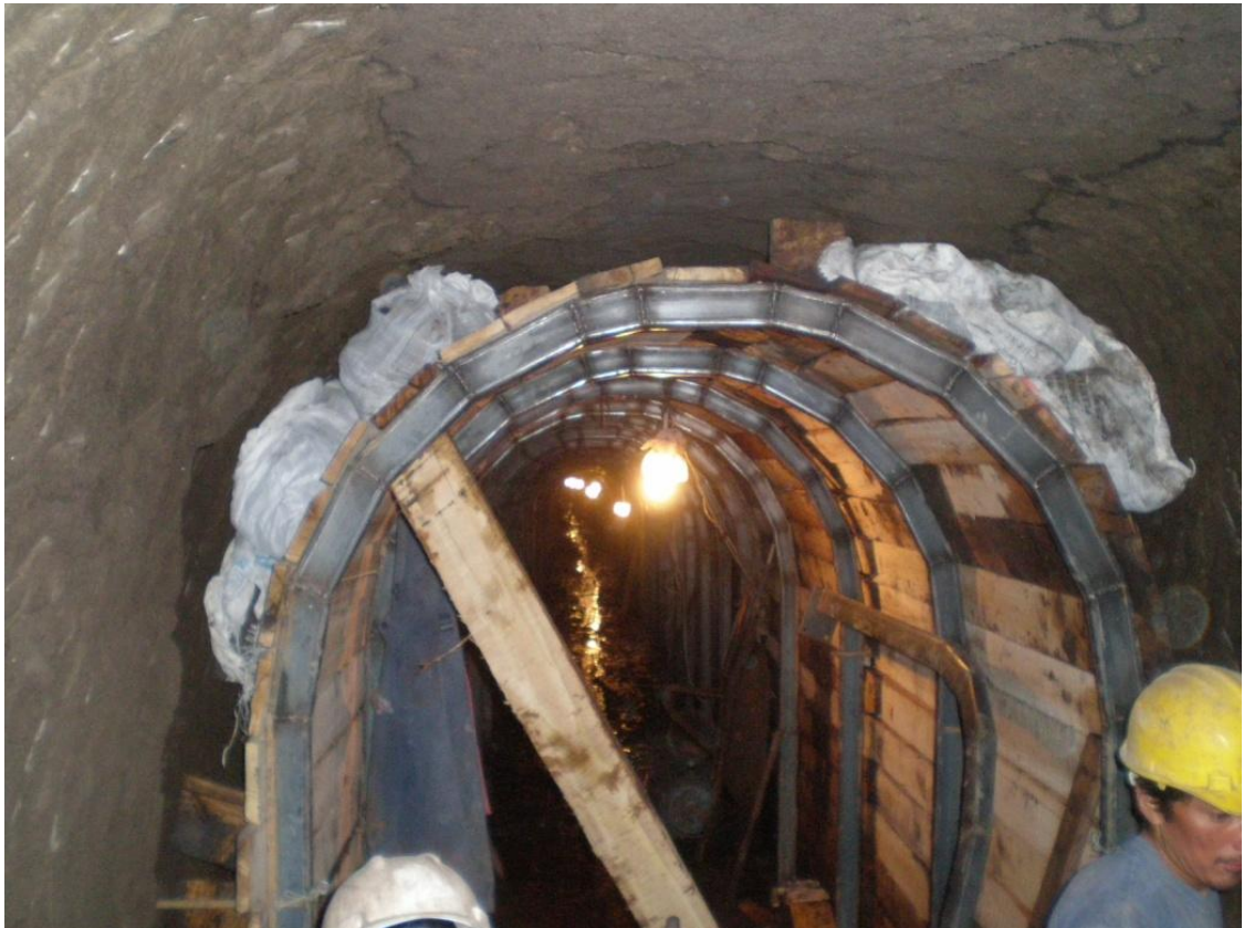
Imagen 3.30. Relleno de sobre excavación luego de colocar el entibado.
