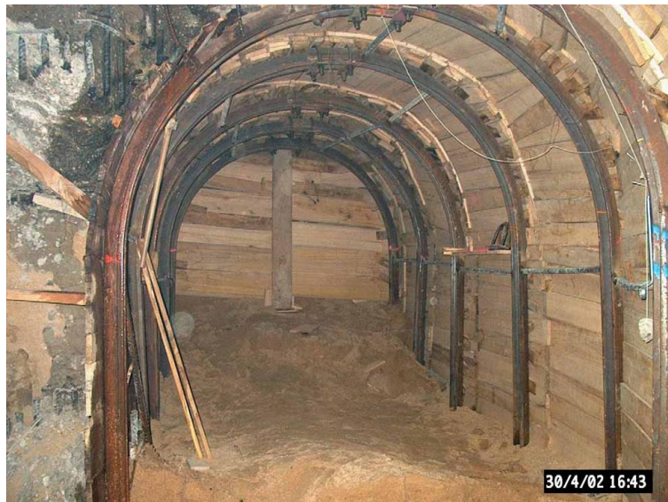
Imagen 1.17 y 1.18. Método Alemán. Ejemplos de excavaciones sucesivas. (CHILE, 2007) 11
