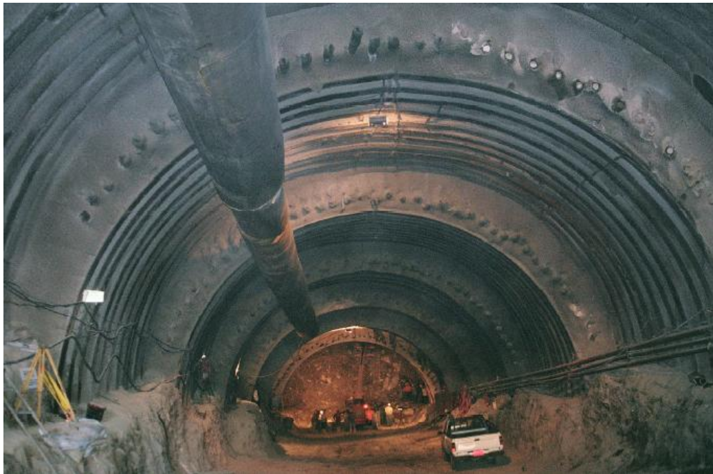
Imagen 1.3. Construcción Túnel Guayasamín. 6
