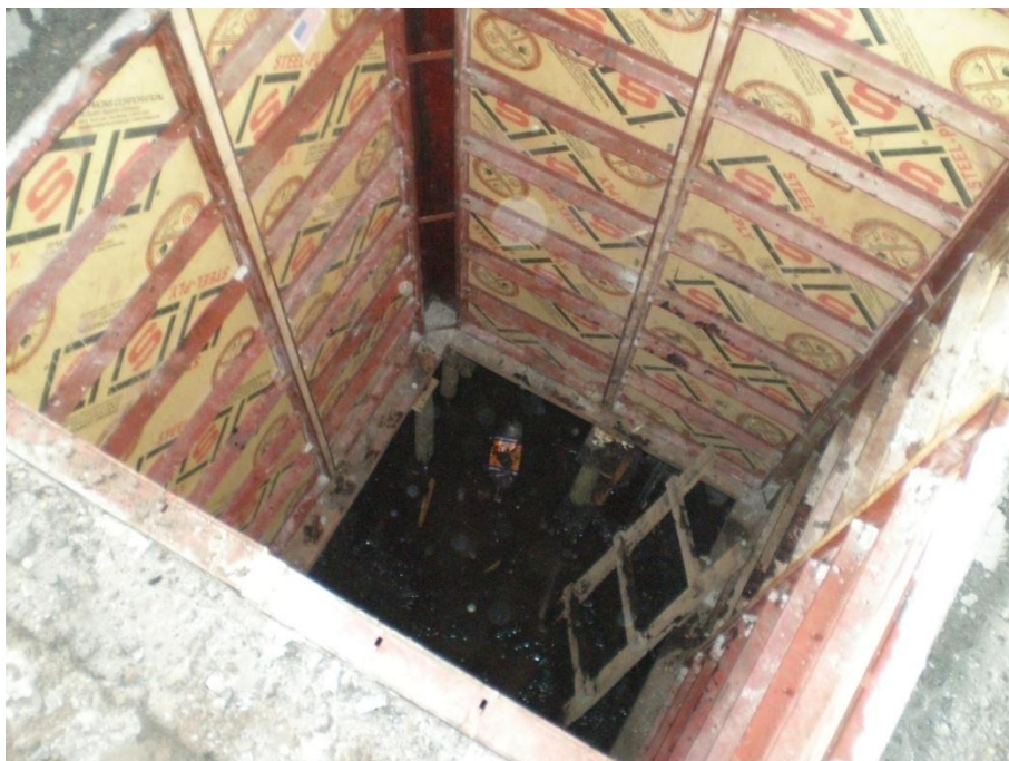
Imagen 3.34. Tableros del encofrado.
