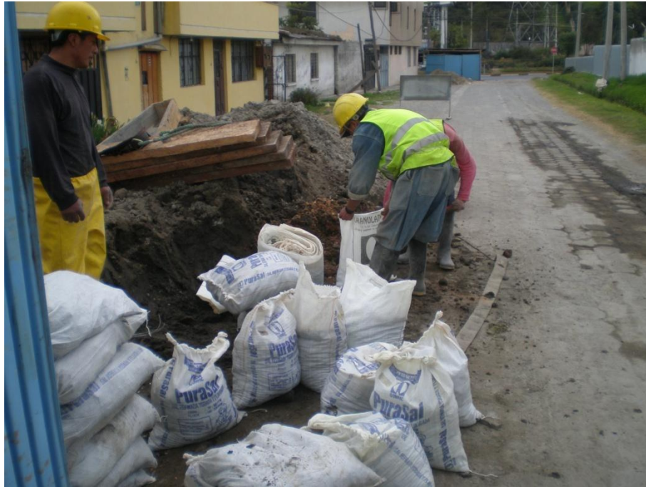
Imagen 3.32. Saquillos con material producto de la excavación, usados para relleno.
