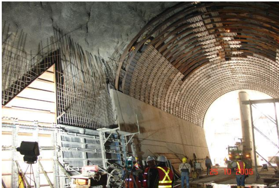
Imagen 1.4. Túnel de Desvío Represa Mazar. 7
