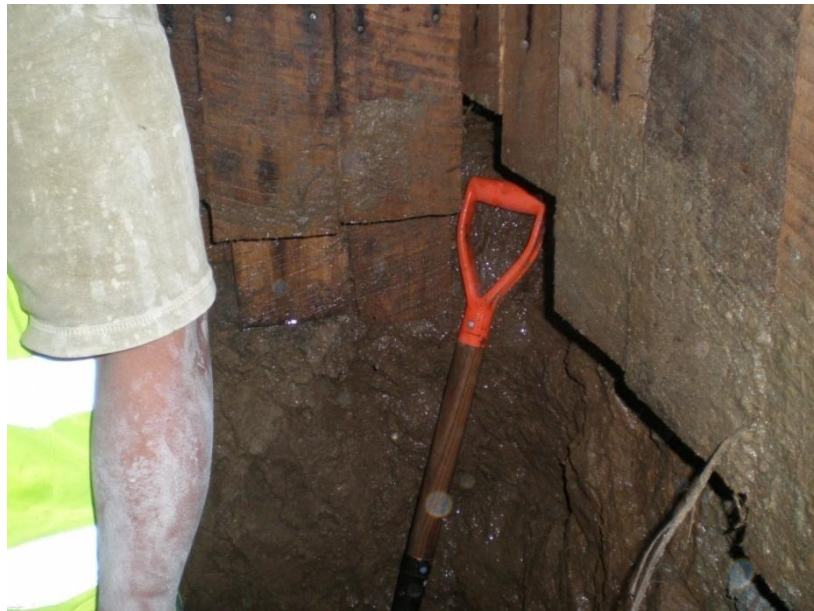
Imagen 3.25. Hincado de tablonces de abajo hacia arriba.
