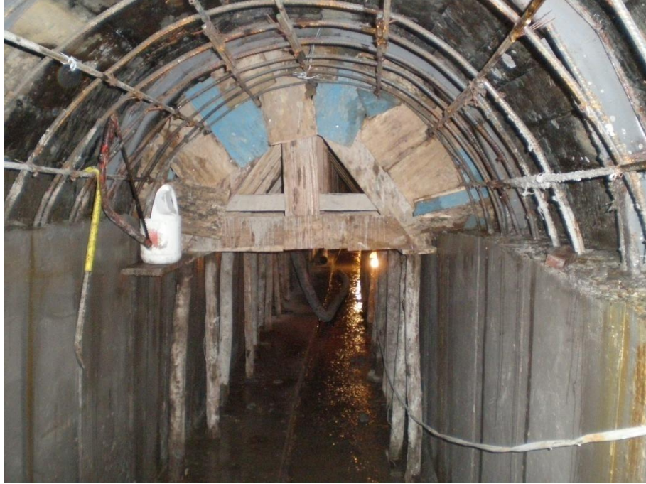
Imagen 3.38. Encofrado y apuntalado de bóveda.
