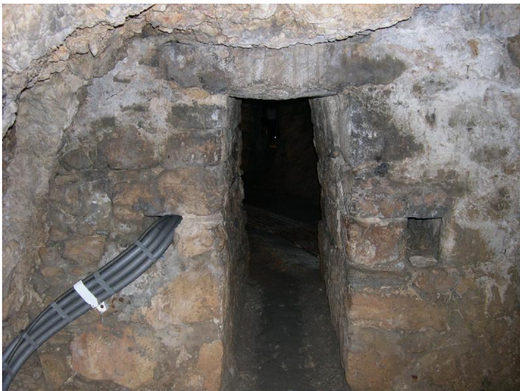
Imagen 1.1. Acueducto construido por Eupalinos 4
