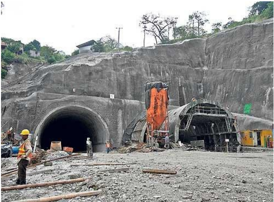
Imagen 1.5. Entrada Túnel San Eduardo. 8
