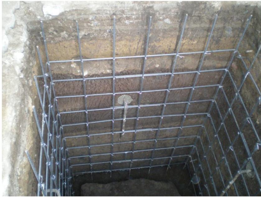
Imagen 3.13. Armadura centrada con separadores.
