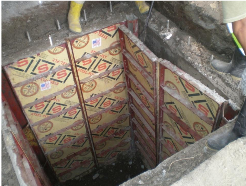
Imagen 3.14. Armado de tableros de encofrado.
