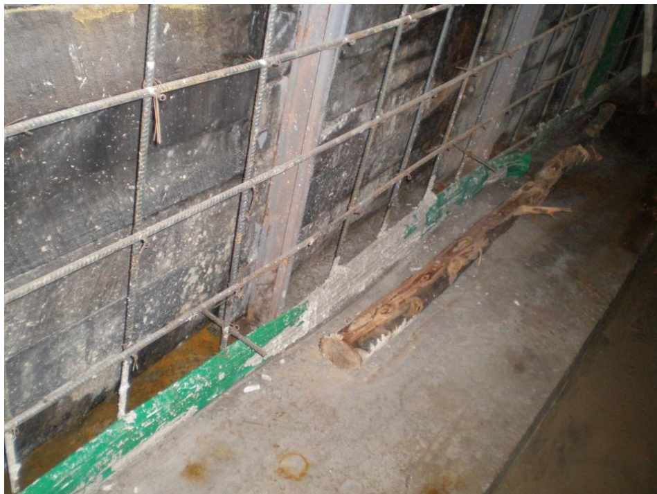
Imagen 3.17. Junta impermeable de PVC.
