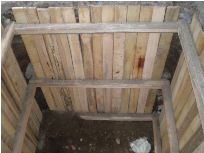
Imagen 3.22. Colocación de entibados.
