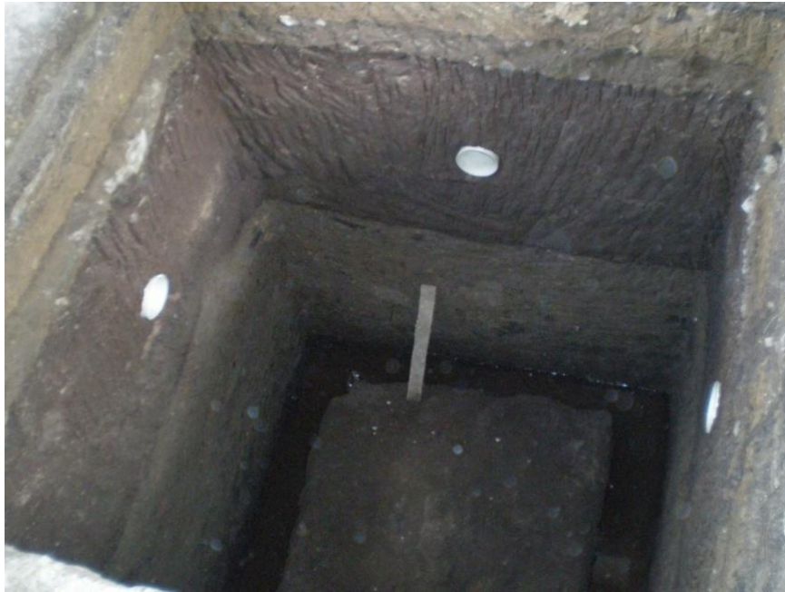
Imagen 3.11. Perfilado de las paredes del pozo.
