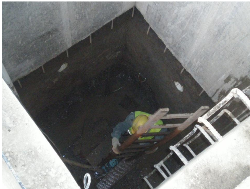
Imagen 3.16. Escalones colocados.
