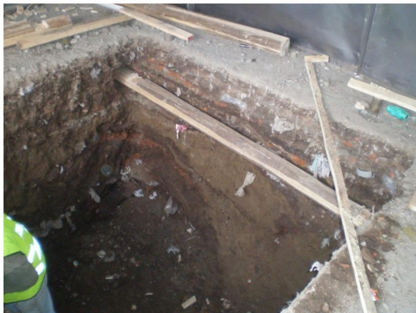
Imagen 3.9. Colocación de entibados.
