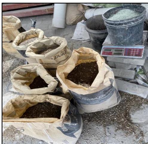
Anexo 8. Preparación de los Materiales para la Fabricación de los Mampuestos Ecológicos tipo Bloque.
