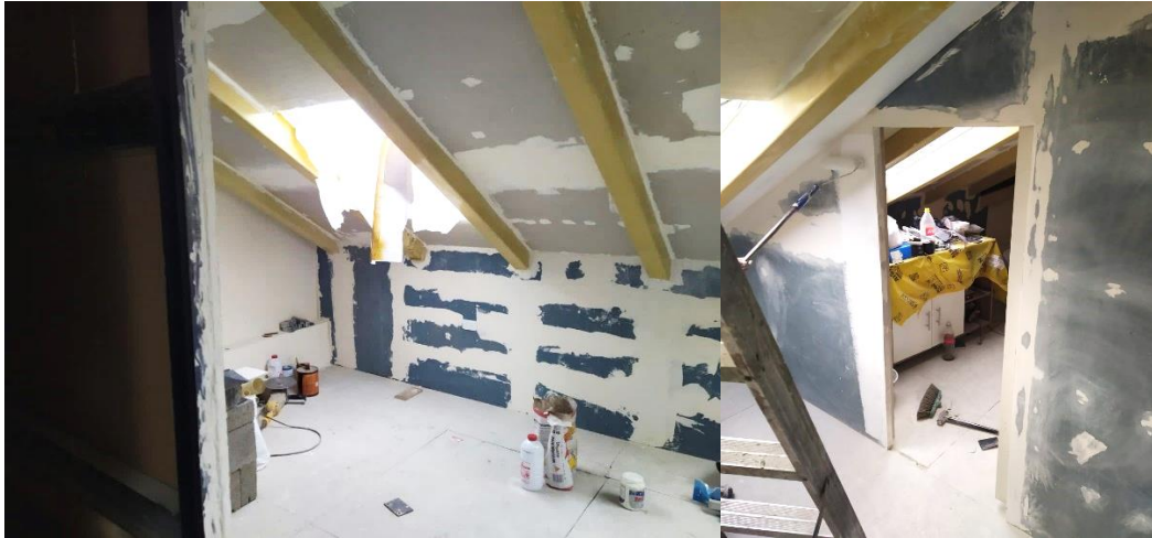
Figura 8: Aplicación de estructura de Gypsum.
