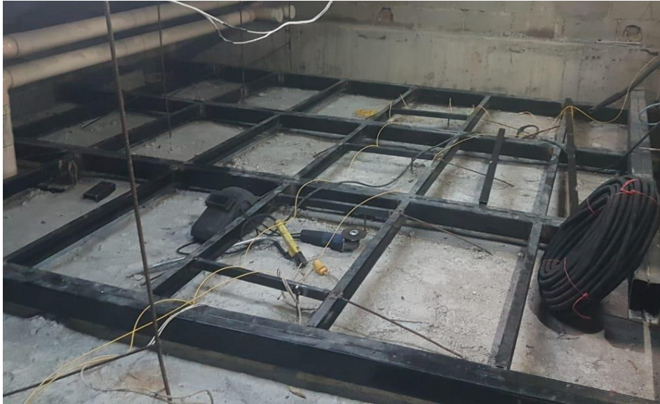
Figura 6: Estructura metálica para fibrocemento. Elaborado por: Johnny Páez
