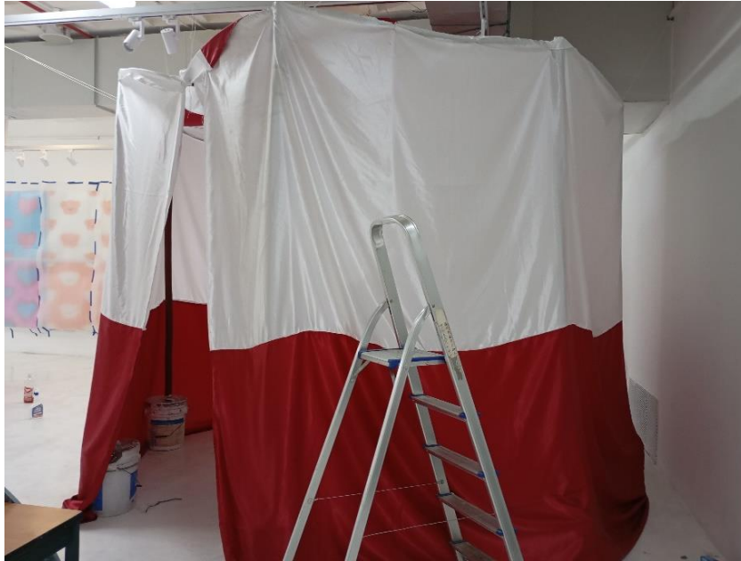
Fig. 43 Cevallos, C., Cevallos, X. (2024) Procesos de montaje de carpa [Instalación]
