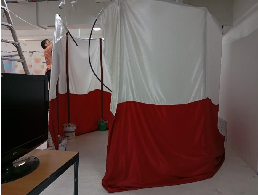
Fig. 41 Cevallos, C., Cevallos, X. (2024) Procesos de montaje de carpa [Instalación]
