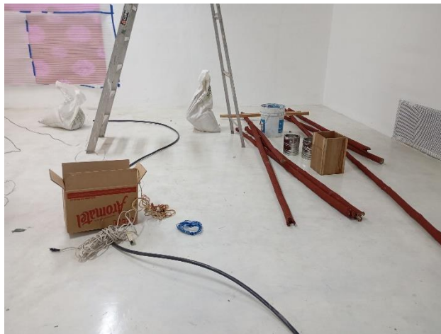
Fig. 39 Cevallos, C. (2024) Materiales y procesos de montaje de carpa [Instalación]
