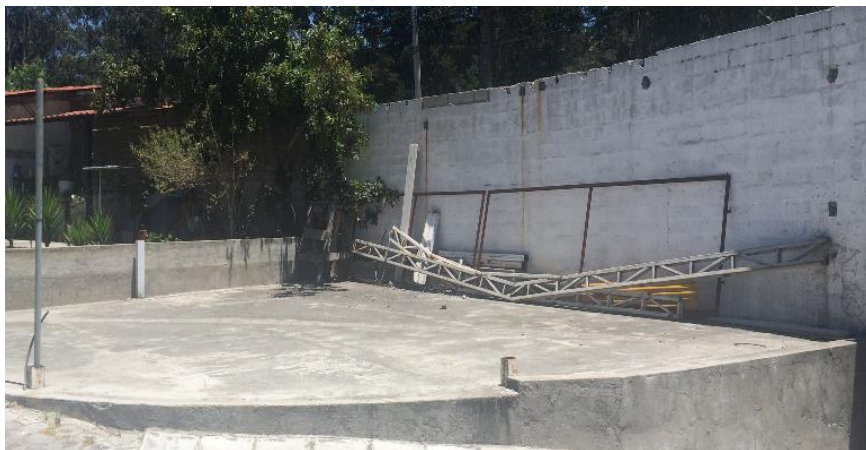
Figura 35: Adecuación bar restaurante
