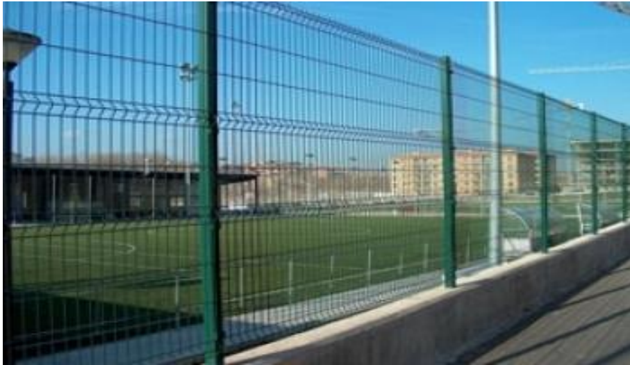
Figura 47: Malla electro soldada
