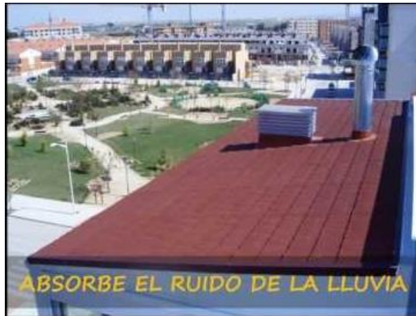
Figura 36: Material del techo
