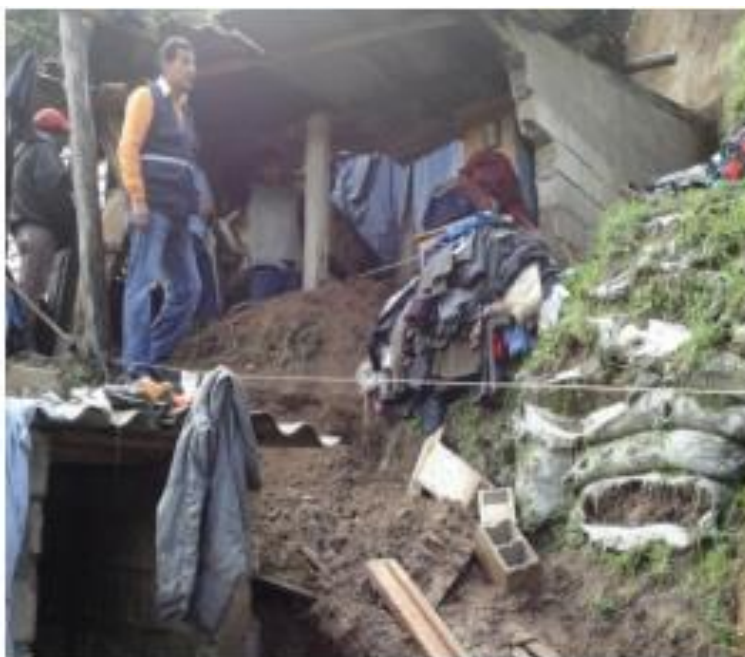
Fotografía 7: Vivienda en riesgo Paluco 2
