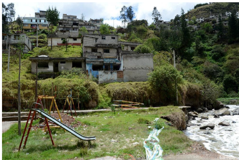
Fotografía 4: Viviendas en zonas de Riesgo: Barrio Paluco
