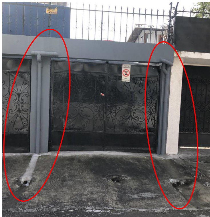
Fotografía 5. Bajantes de cubierta hacia la vía
