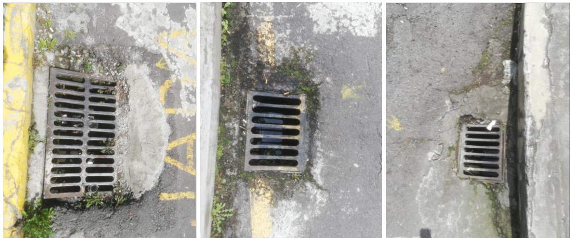
Fotografía 22. Rejillas de sumideros con sobre depresión
