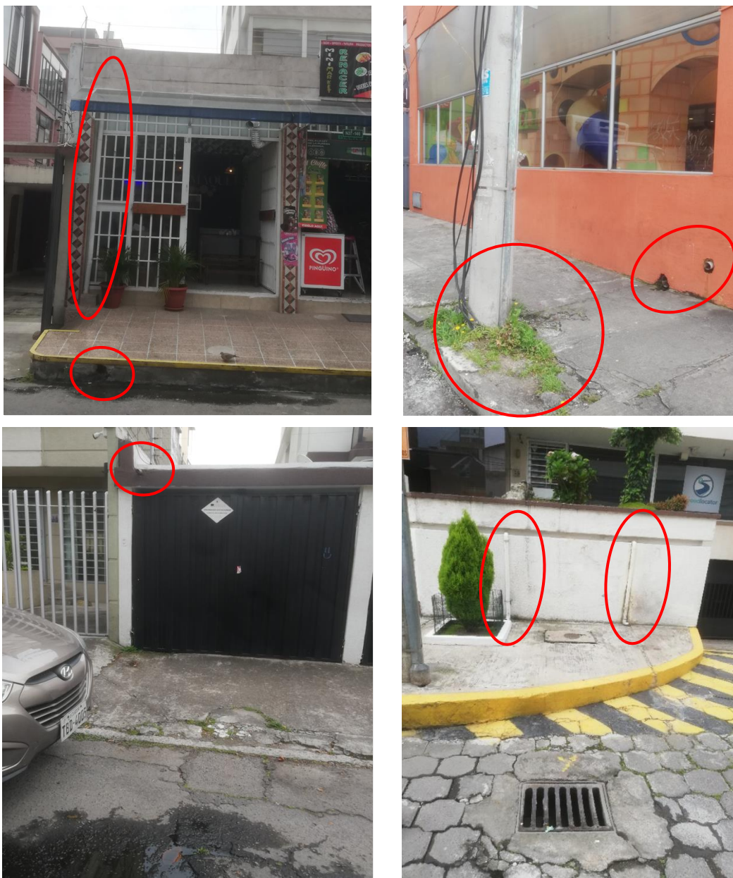
Fotografía 23. Bajantes de predios privados con descarga hacia la calle
