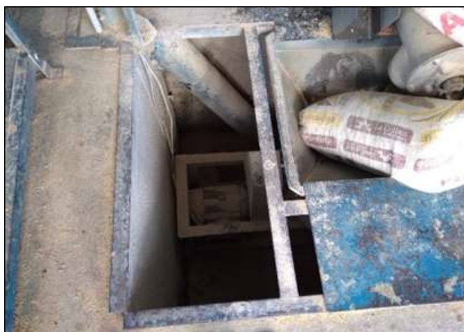
Registro fotográfico 5. Molino para la trituración de materias primas
