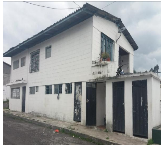
Instalaciones del cementerio Fotografía: Camila Yépez. Cementerio “Parques del Recuerdo”
