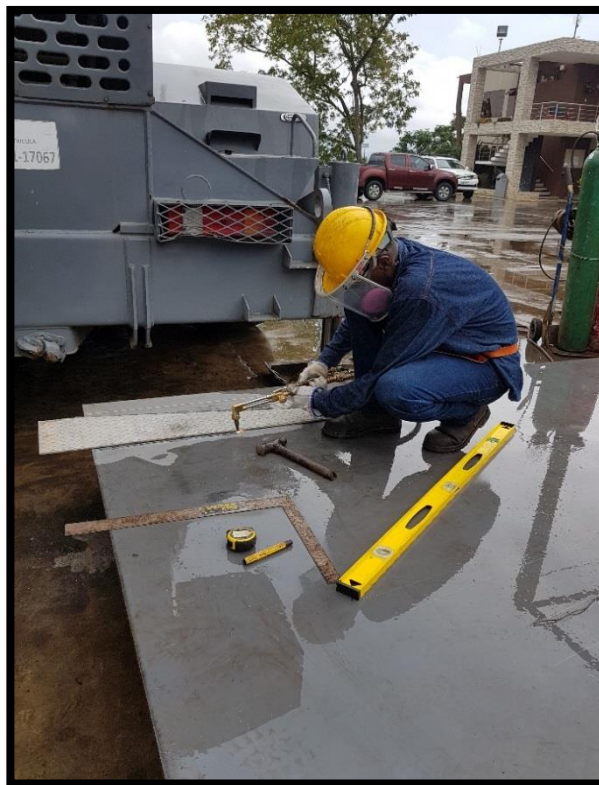
Figura Nro. 4. Medición y marcado de material
