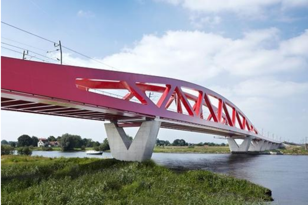
Fig. 1.1 Zwolle Railroad Bridge, Países Bajos (structurae.net, 2012)
