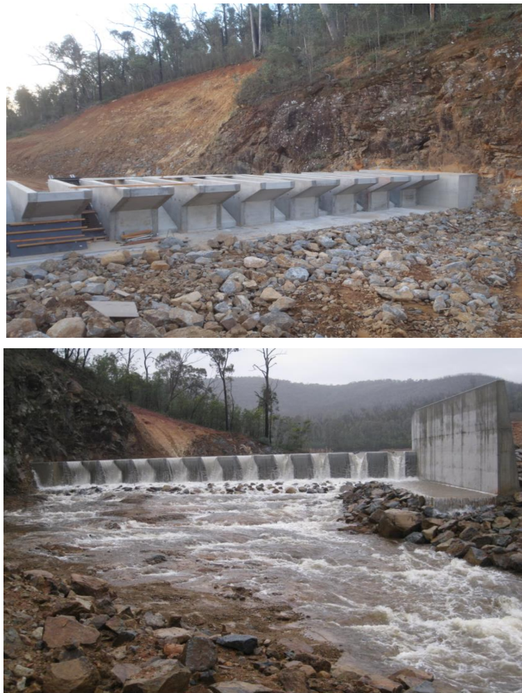
Figura 6. Vertedero tipo tecla de piano presa Australia Benalla Victoria
