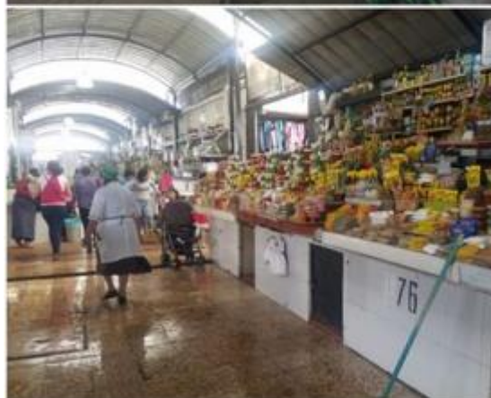
Mercado tipo galpón, locales contiguos y estructuras añadidas
