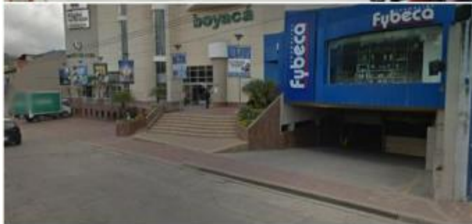
Tipología de centro comercial en altura, parqueaderos en subsuelo y en el frente, Centro Comercial El Valle, Loja
