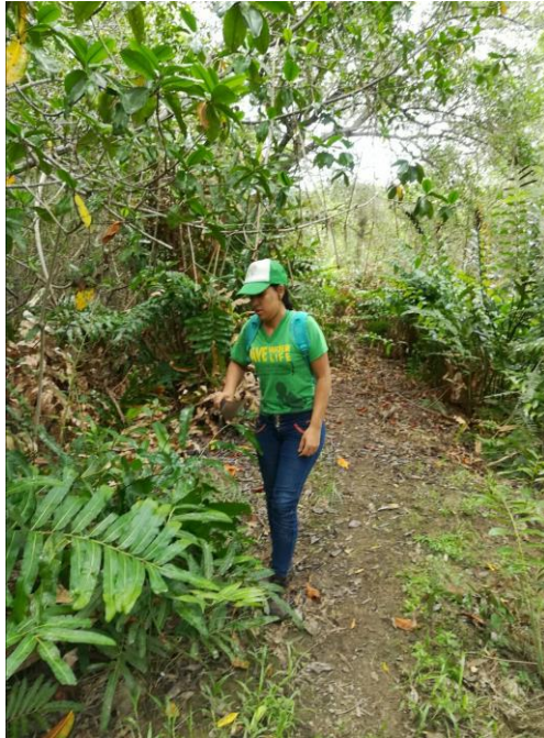
Figura 13 Limpieza del terreno
