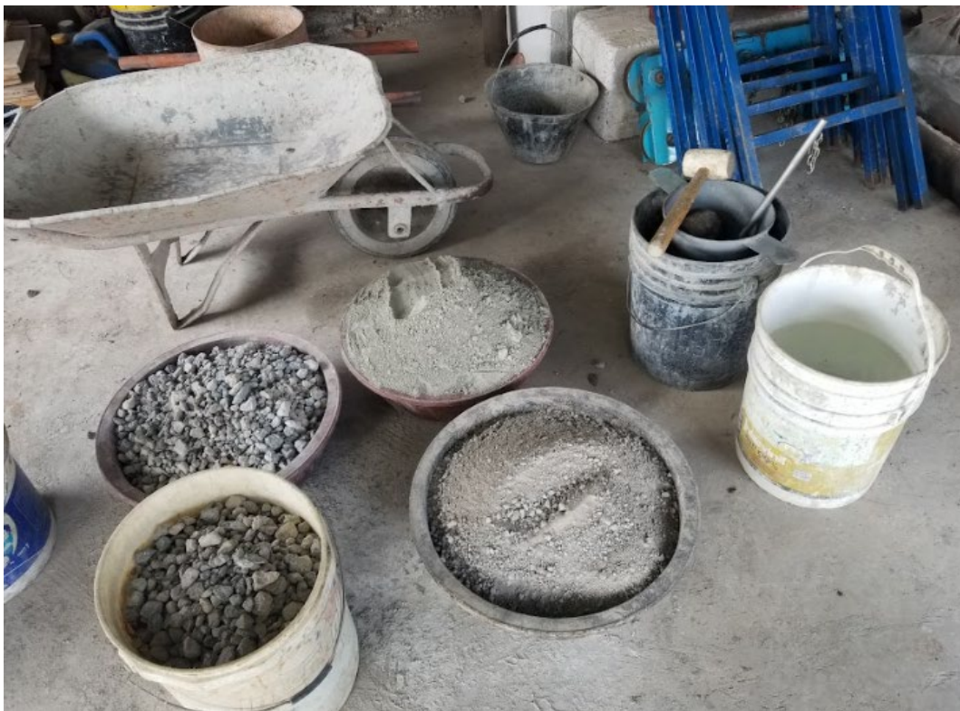
Dosificación de materiales para la elaboración de mezcla de hormigón
