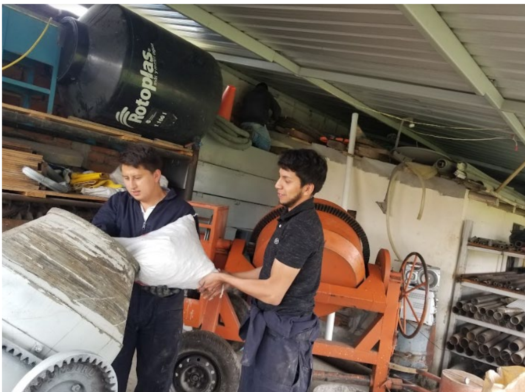
Elaboración de la mezcla en campo
