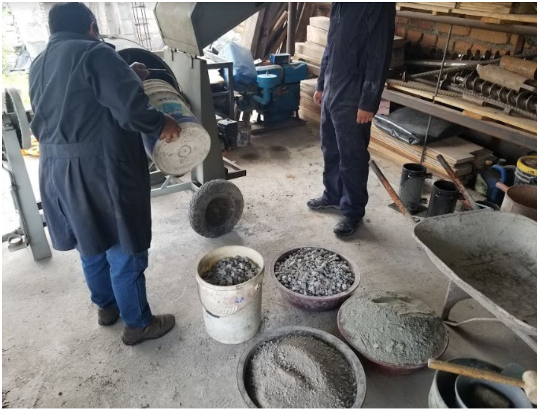
Elaboración de la mezcla en campo
