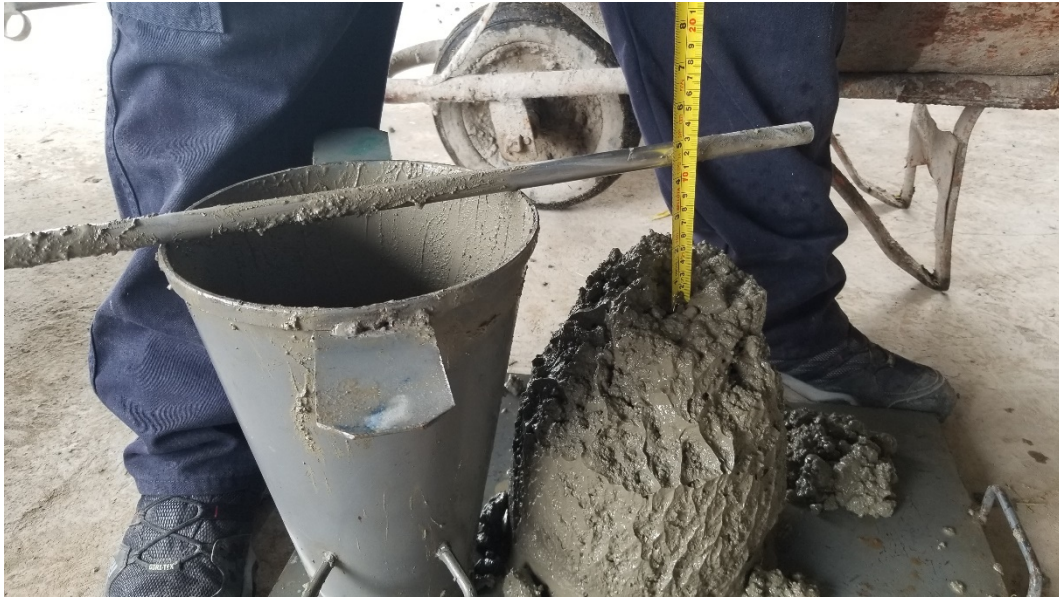
Medición de asentamiento
