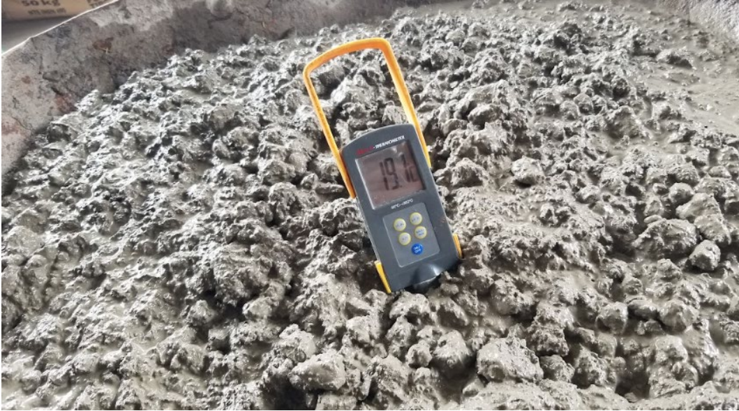
Toma de temperatura en el hormigón
