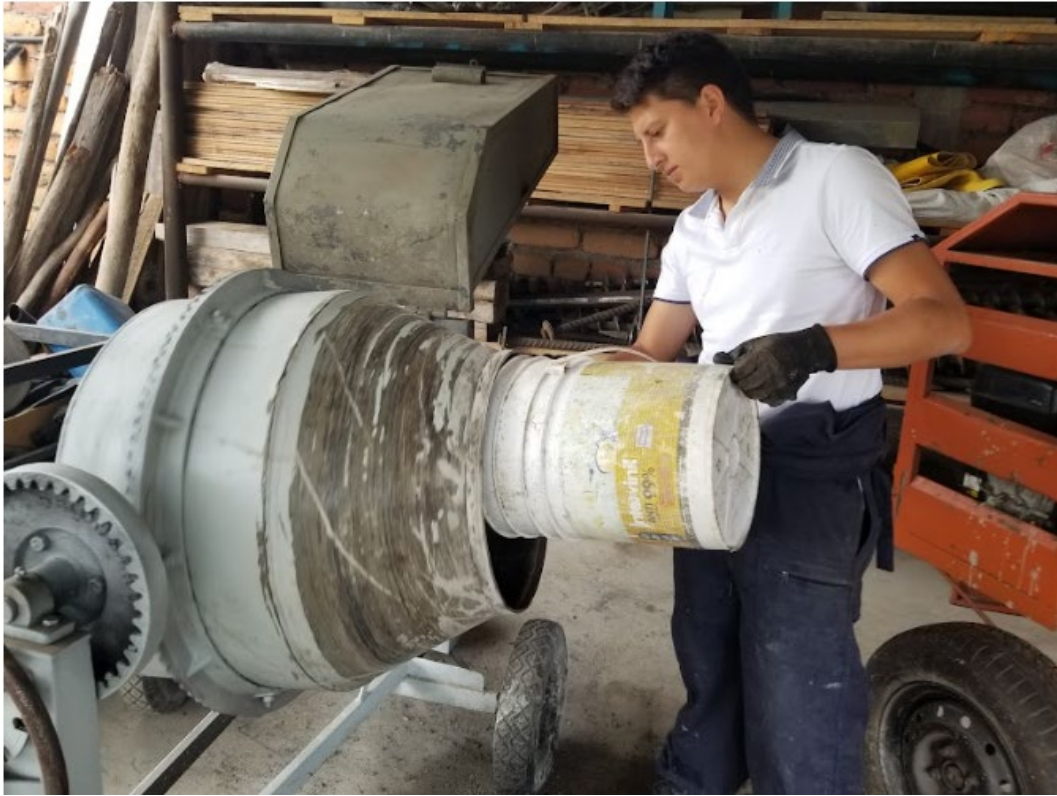
Elaboración de la mezcla en campo
