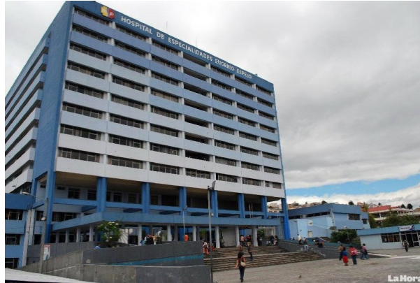
Fachada principal Hospital de Especialidades Eugenio Espejo
