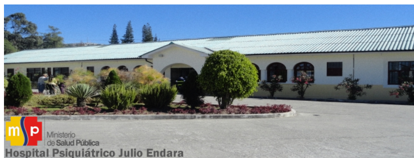
Bloque de ingreso Hospital Psiquiátrico Julio Endara
