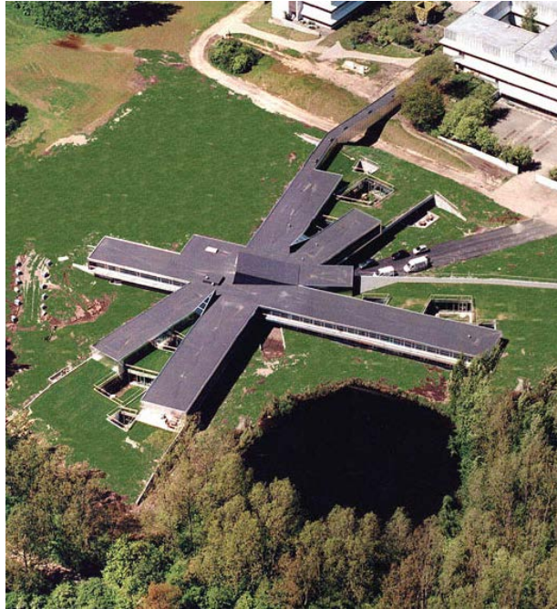
Implantación Hospital Psiquiátrico Helsingor
