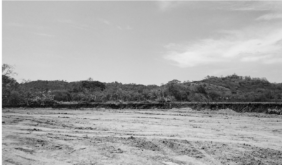
Fotografía 4: Vista de nivelación del terreno
