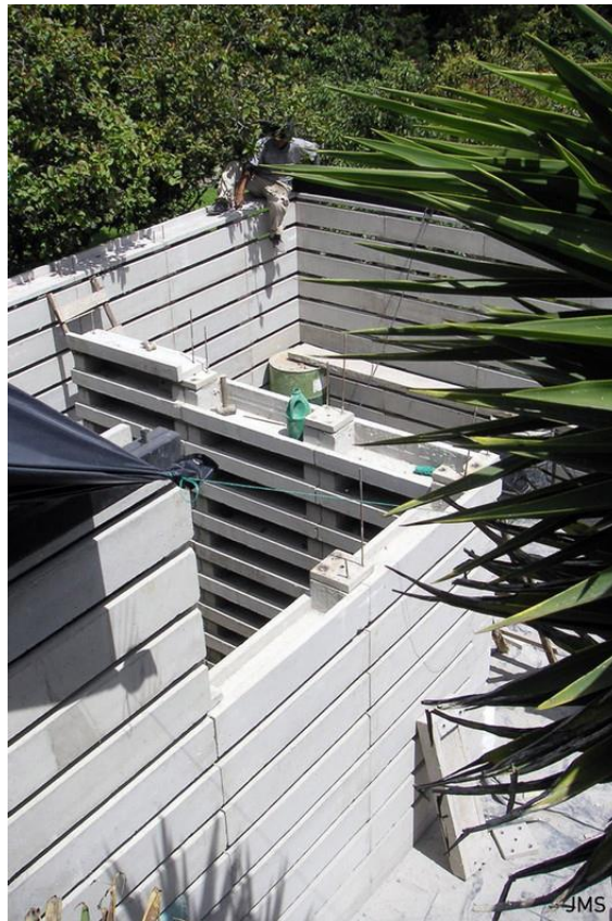
Imagen 11: Casa pentimento en construcción
