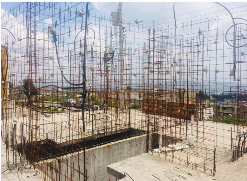
Gráfica 6. Fotografía. Armado de muro con malla electro-soldada. Fuente propia .
