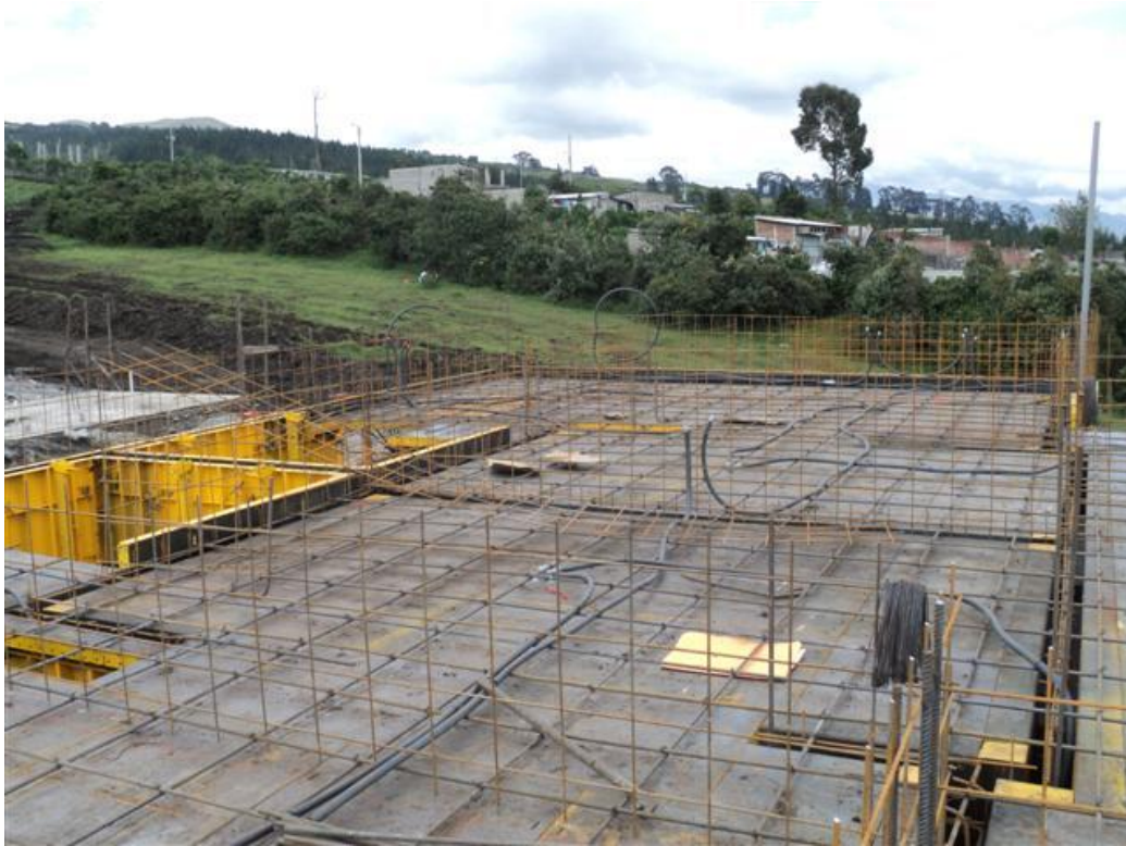
Gráfica 11. Fotografía. Losa de entepiso. Fuente: (Eco&Arquitectos, 2017).
