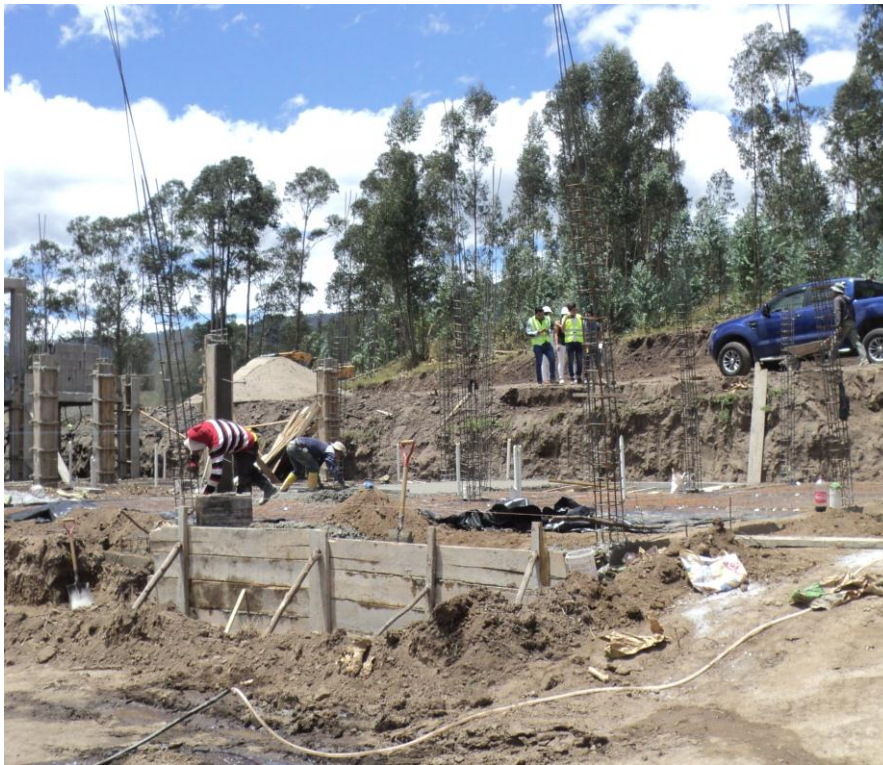
Gráfica 22. Fotografía. Armado de columnas. Fuente propia.
