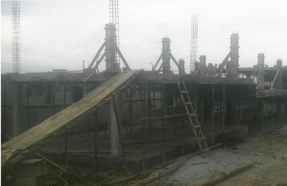
Gráfica 25. Fotografía. Encofrado de losa alivianada. Fuente propia.
