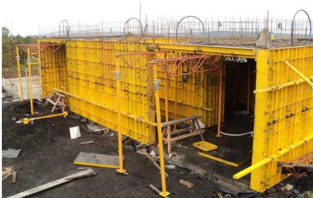
Gráfica 7. Fotografía. Instalación de formalelas. Fuente: (Eco&Arquitectos, 2011).
