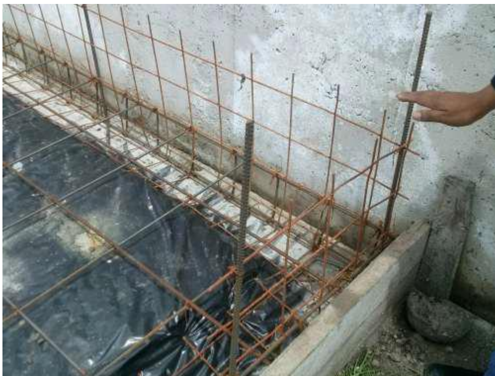
Gráfica 14. Fotografía. Esquina de muro portante, unión con losa de contrapiso. Fuente: (Eco&Arquitectos, 2017).
