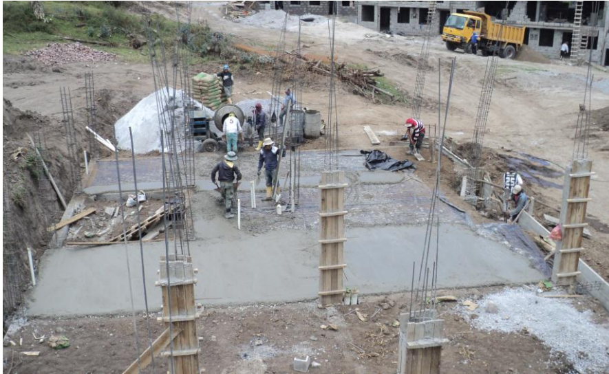
Gráfica 24. Fotografía. Construcción contrapiso. Fuente propia.
