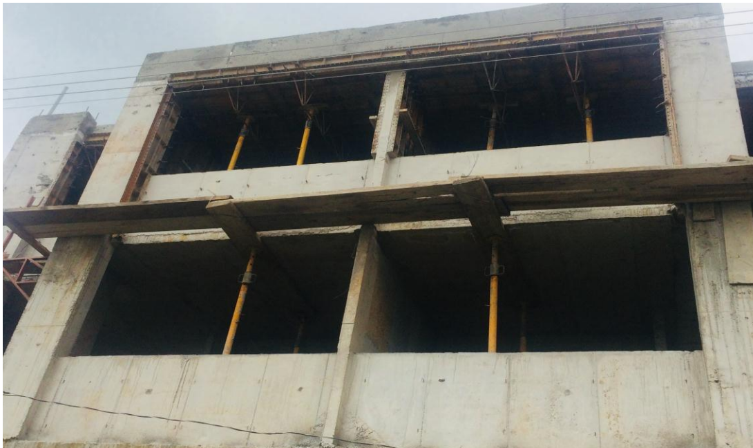
Gráfica 13. Fotografía. Losa de entresuelo y cubierta, fundidas. Fuente propia.
