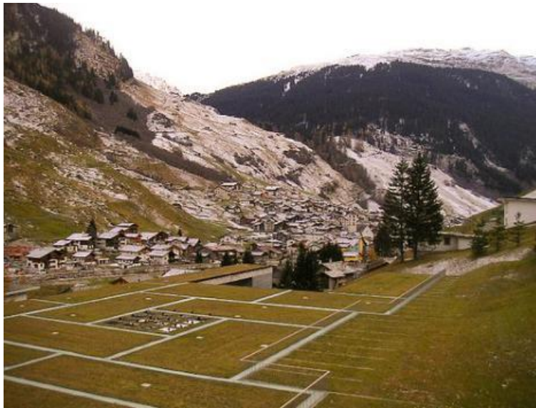
Fotografía 5: Cubierta de las Termas de Vals
