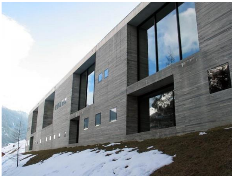
Fotografía 6: Fachada Frontal de las Termas de Vals
