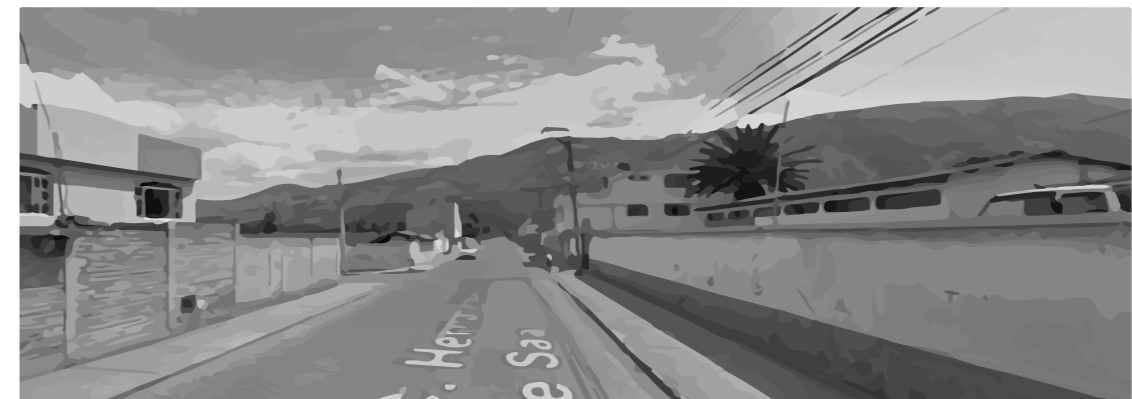
FIGURA 29 ESTADO ACTUAL DE LA CALLE "HERNÁN GONZÁLES DE SAÁ"
