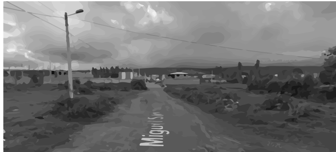
FIGURA 31 ESTADO ACTUAL CALLES DE TERCER ORDEN
