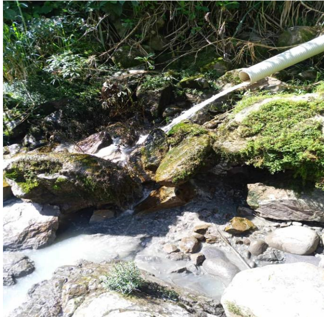
Figura 15: Desembocadura de aguas residuales
