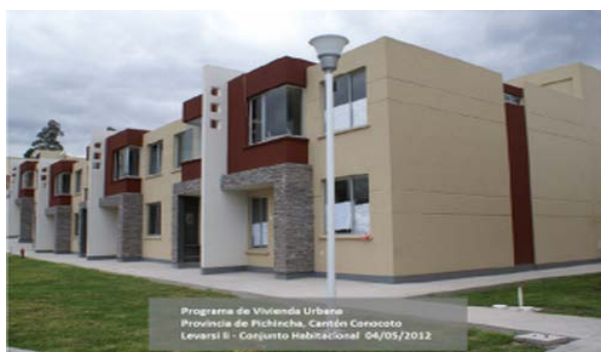
Fotografía 9. Proyecto de Vivienda Urbana "Conj. Levarsi II"
