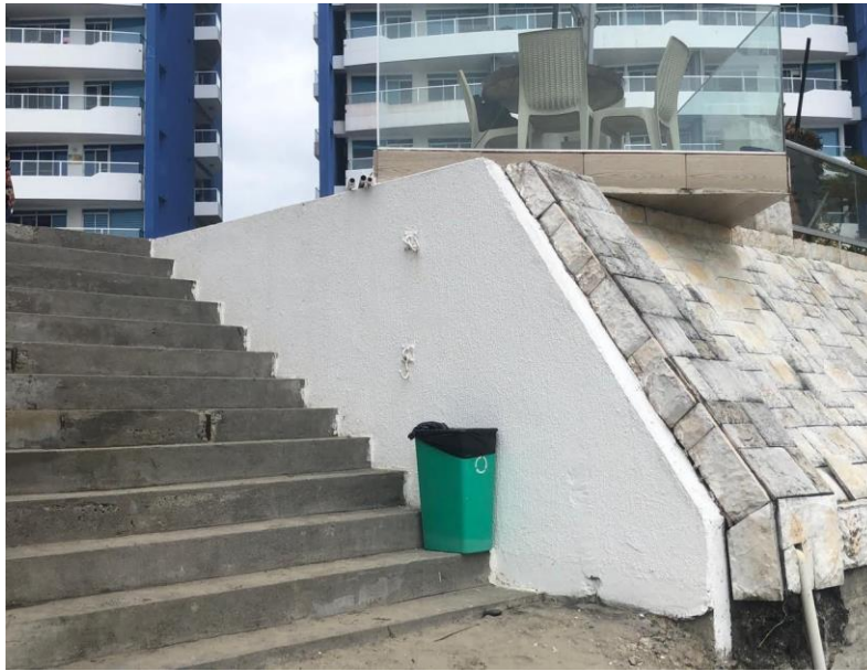
Figura 30. Segundo punto de depósito para desechos. Elaborada por el autor
