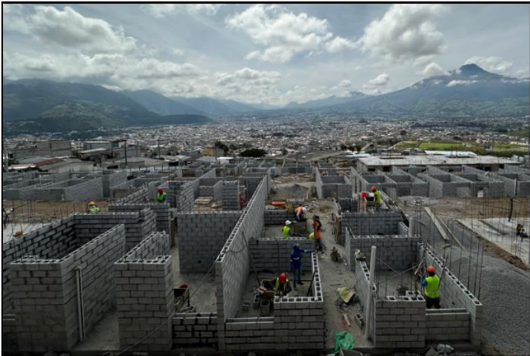
Imagen 1: Construcción Proyecto “San Miguel Arcángel”
