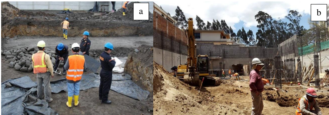
Figura 7a y 7b. Reforzamiento de suelos con material pétreo y/o tierra removida. (ECUASUELOS21, 2017)
