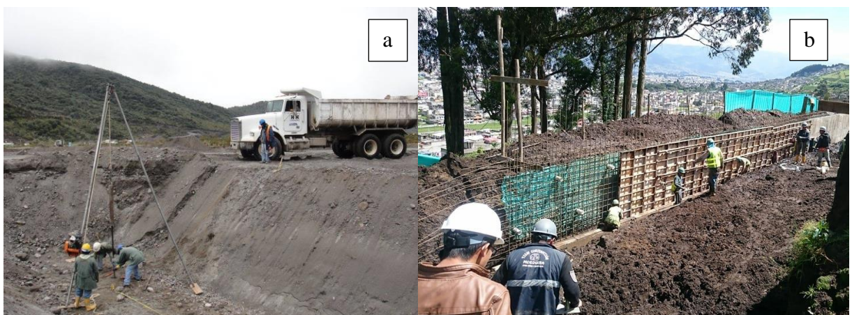
Figura 4a y 4b. Preparación de terreno para nivelación. (ECUASUELOS21, 2017)
