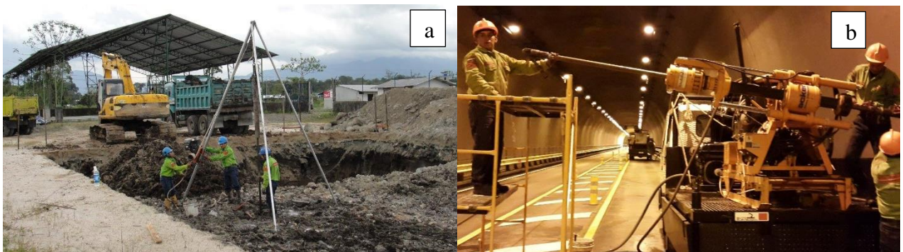
Figura 3a y 3b. Ensayo de perforación SPT. (ECUASUELOS21, 2017)
