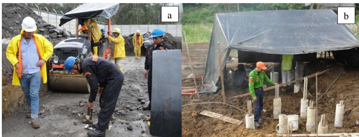
Figura 6a. Compactación del suelo mediante paso de aplanadora y Figura 6b. Pilotes de compactación. (ECUASUELOS21, 2017)
