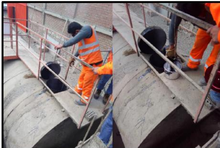
Figura 3.1. Extracción de cemento asfáltico para la investigación.
