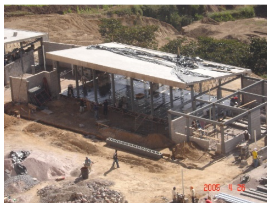
Fotografía 2: Construcción Liceo Campo Verde
