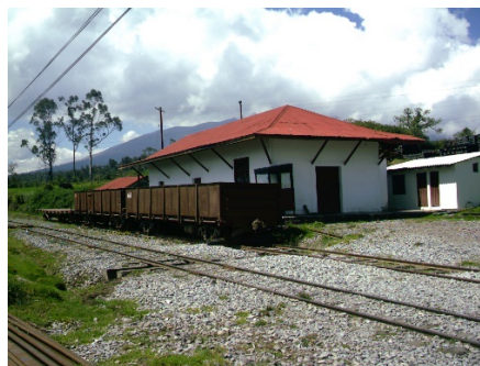
Fotografía 7: Estación de Alóag
