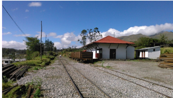
Fotografía 6: Estación de Alóag
