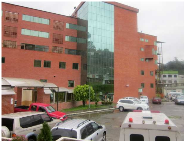
Figura 48. Vista exterior de un Hospital Universitario
