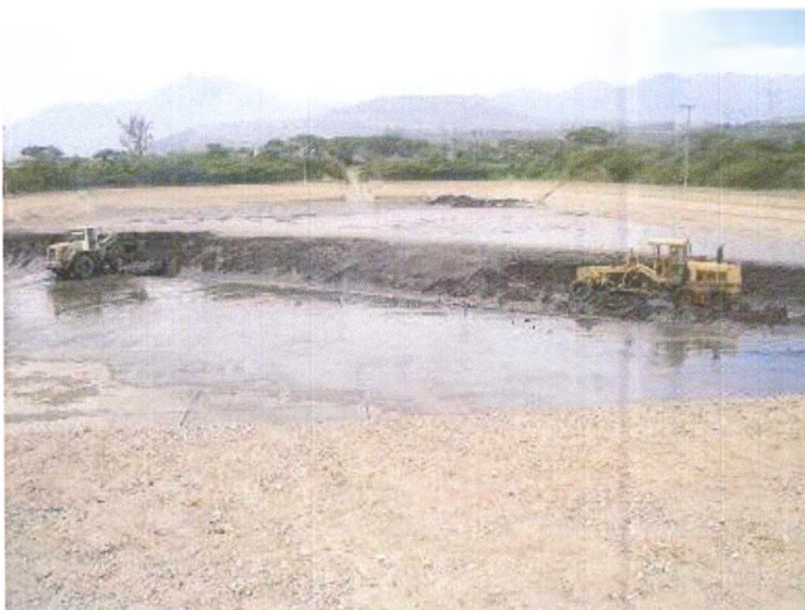
Figura 25 Limpieza del reservorio (lodo)
