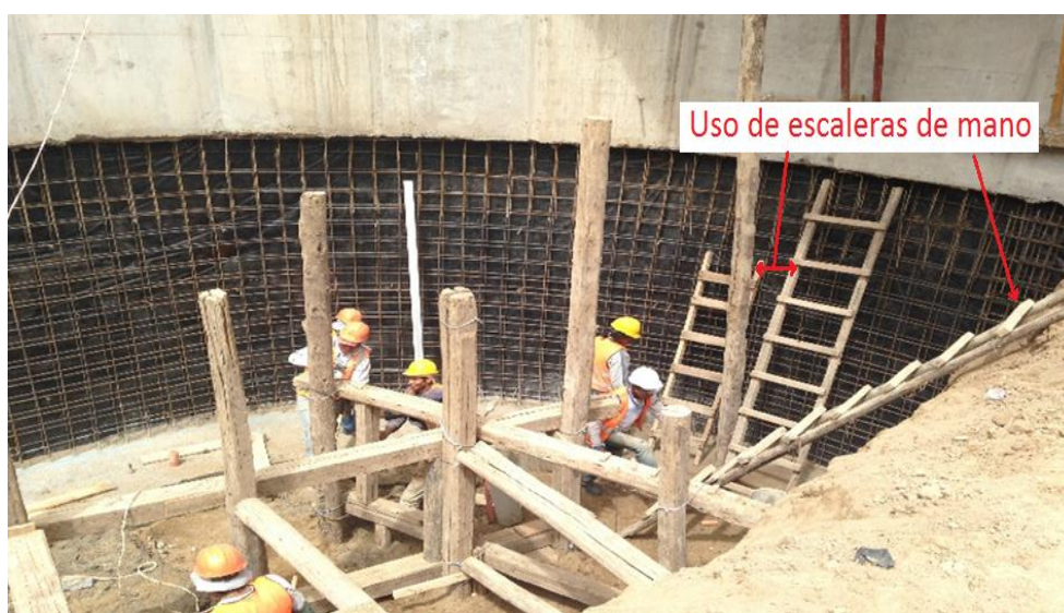
[Imagen de excavación, escaleras, pasarelas, pasos provisionales]. Fuente: elaboración propia
