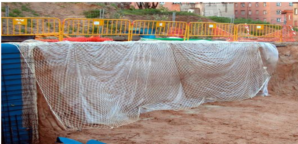
[Imagen de excavación, obstáculos, suelo des uniforme]. Recuperado de Edificación Samenthi
