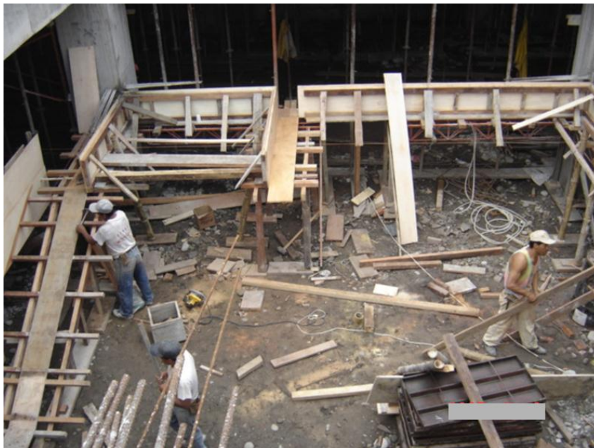
[Imágenes de área de encofrados]. Recuperado de evaluación propia
