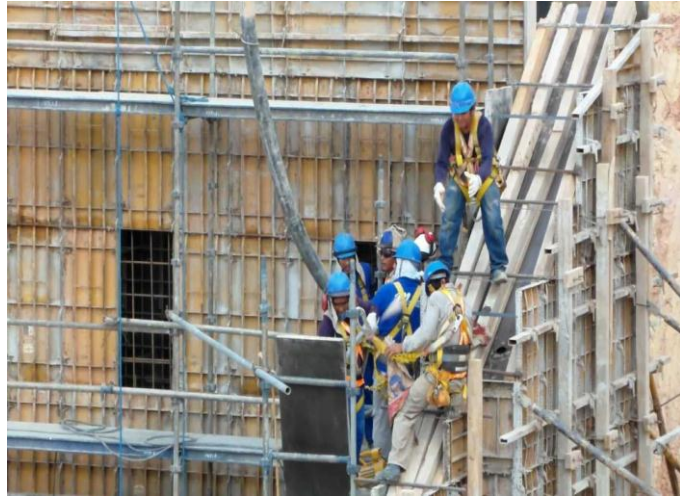
Imagen de fundido con tubería de vertido de hormigón. http://i.ytimg.com/vi/ZzPhyujb4r0/hqdefault.jpg
