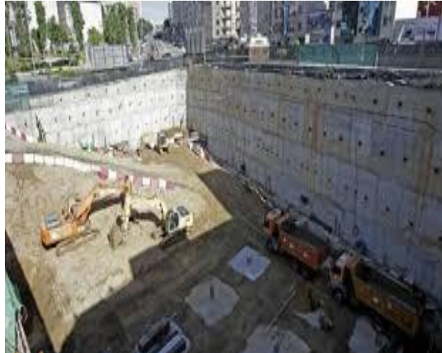
[Imagen de excavación, suelo des uniforme]. Fuente: elaboración propia
