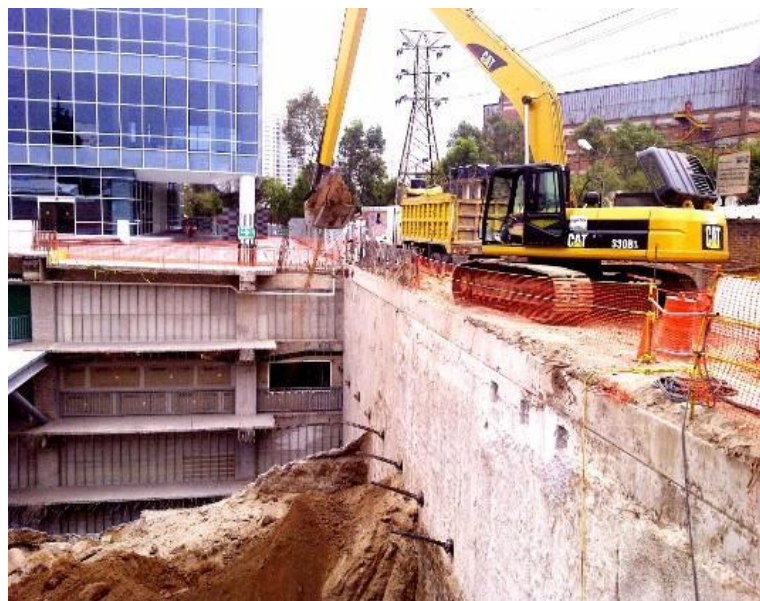
[Imagen de excavación profundidades mayores a 5 m. Recuperado de Edificio Tifíno
