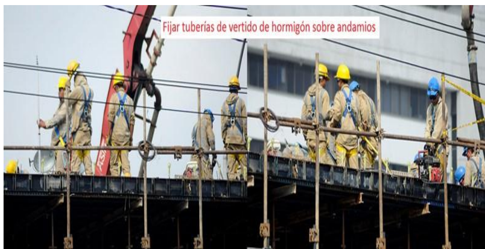
[Imagen de trabajadores sobre andamios, tuberías de vertido de hormigón. Recuperado de http://www.alquilerdeandamios.org/venta/venta-andamios.jpg
