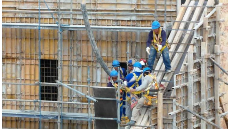
[Imagen de fundición sobre andamios. Recuperado https://i.ytimg.com/vi/ISyKvqge6eM/maxresdefault.jpg
