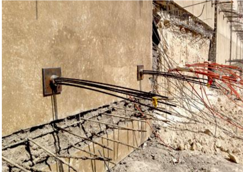
[Imágenes de armado de perforación del tirante del anclaje]. Recuperado de https://www.google.com.ec/search?biw=1707&bih=844&tbm=isch&sa=1&ei=6V-pWrlIBOPs_QaEpoqIBg&q=perforacion+del+muro+anclado&o
