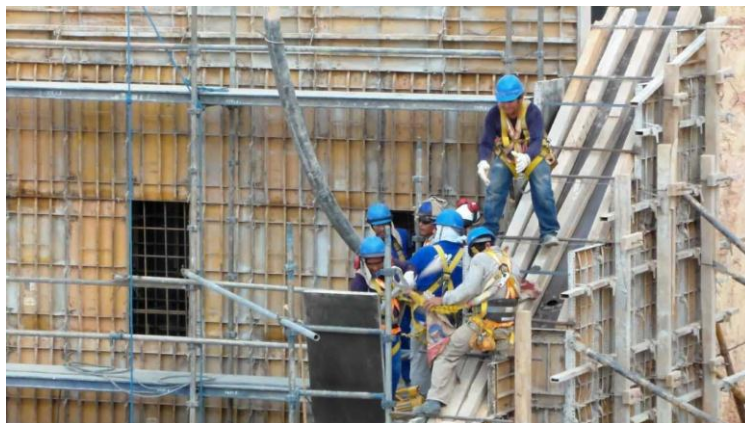
[Imagen de fundición sobre andamios. Recuperado https://i.ytimg.com/vi/ISyKvqge6eM/maxresdefault.jpg
