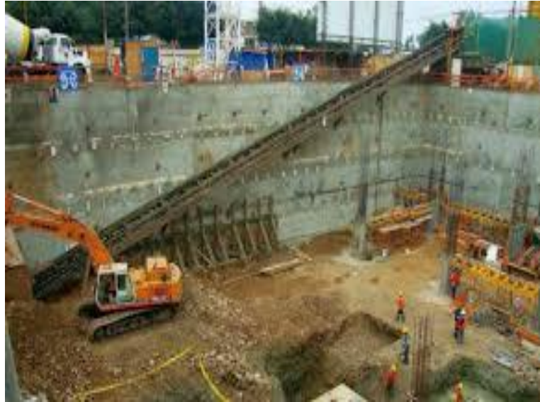
[Imagen de excavación profundidades mayores a 5 m. Recuperado de https://www.google.com.ec/search?q=excavaciones+profundas+construccion&tbn=isch&source
