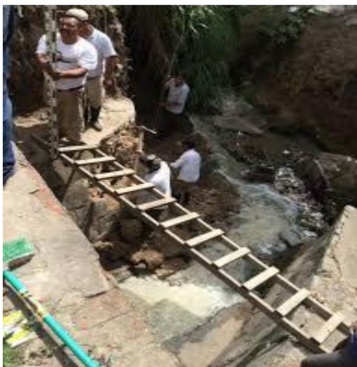
Imagen de uso de escalera en fundido con tubería de vertido de hormigón https://www.google.com.ec/search?q=fundicion+de+muros&tbs=isch&tbs
