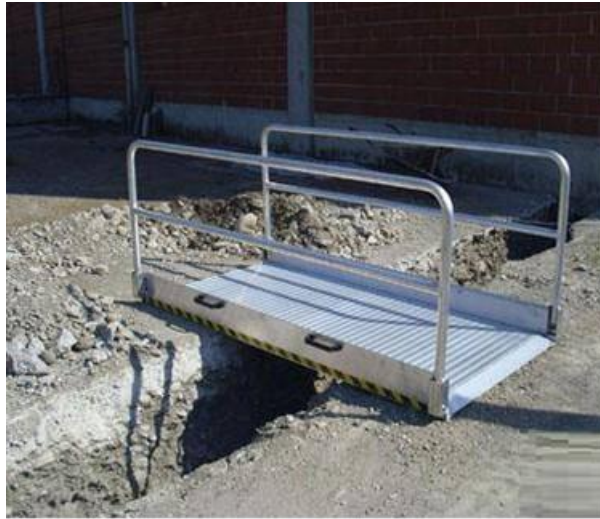
[Imagen de cubierta protecciones colectivas. Recuperado de Edificio Estrella IX, https://www.interempresas.net/FotosArtProductos/P102830.jpg https://www.google.com.ec/search?biw=1707&bih=844&tbn=isch&sa=1&ei=pKWqWuWcBoK4ggfzqKWgAw&q=maquina
