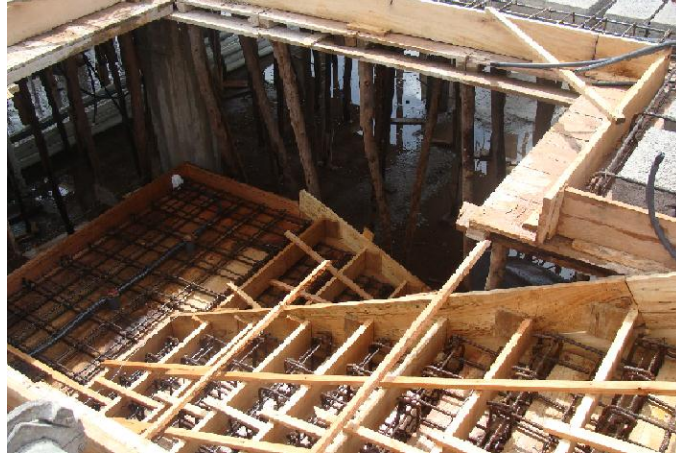
[Imagen de pasamanos provisionales en escaleras]. Recuperado de evaluación propia
