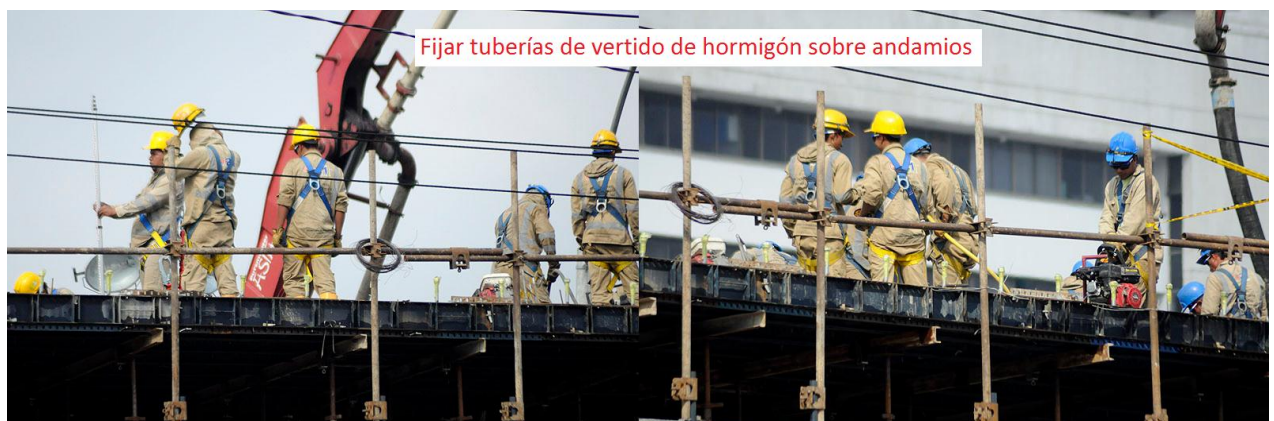
[Imagen de trabajadores sobre andamios, tuberías de vertido de hormigón. Recuperado de http://www.alquilerdeandamios.org/venta/venta-andamios.jpg
