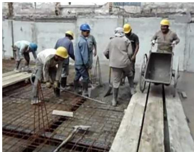
[Imagen de limpieza y orden en fundición de losa]. http://i.ytimg.com/vi/ZzPhyujh4r0/hqdefault.jpg
