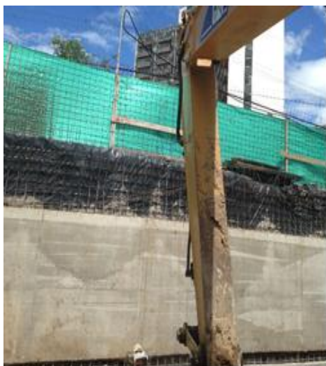
[Imágenes de protección perimetral]. Recuperado de Edificio Tufiño
