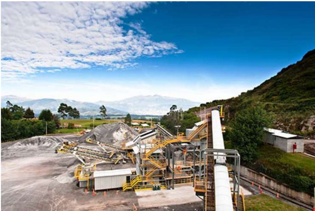
Ilustración 4. Pilas de Material Pétreo (Holcim Pifo, 2019).
