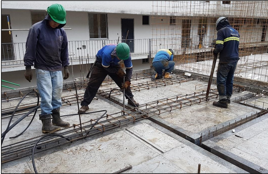
Fotografía 4. Armado y figurado de acero en vigas de losa de entrepisos, Marzo-2017.
