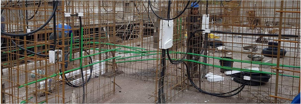
Fotografía 7. Instalación red agua fría y caliente, Febrero-2017.
