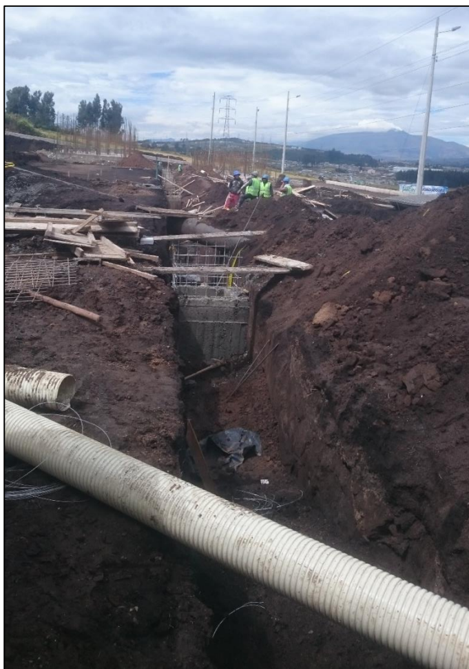
Fotografía 8. Tendido interno de tuberías de alcantarillado, Septiembre-2016.
