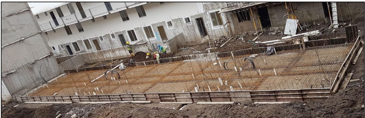
Fotografía 2. Armado in-situ de acero de refuerzo en losa de cimentación, Febrero-2017.
