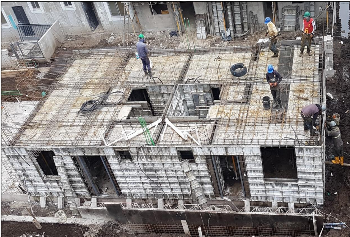
Fotografía 3. Encofrado in-situ de muros portantes, Febrero-2017.
