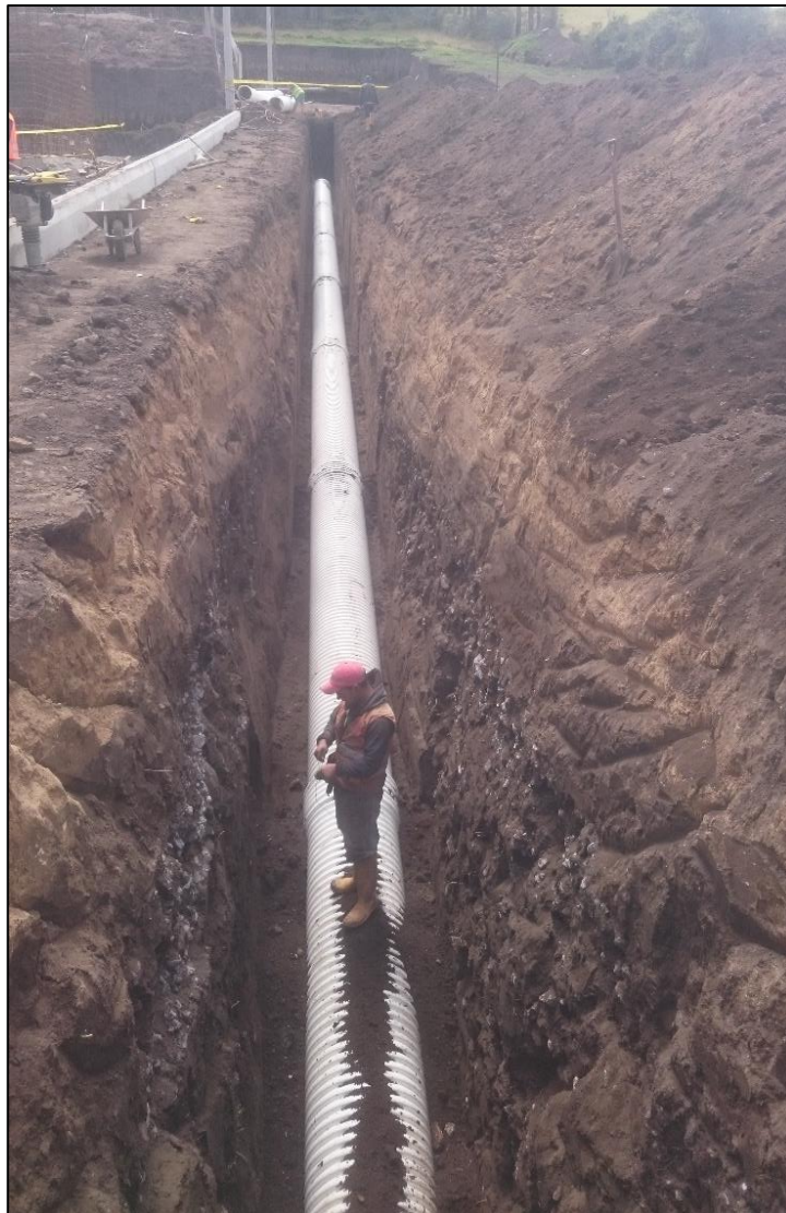
Fotografía 9. Tendido tuberías de alcantarillado en vía pública, Octubre-2017.
