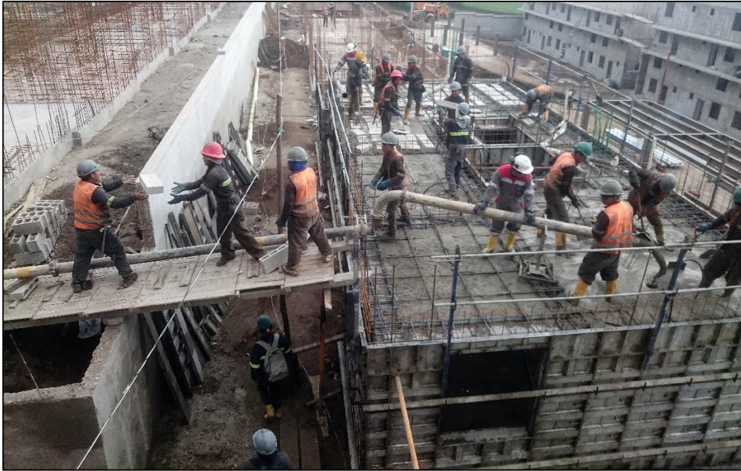
Fotografía 5. Fundición de hormigón en diafragma horizontal y muros portantes, Diciembre-2016.
