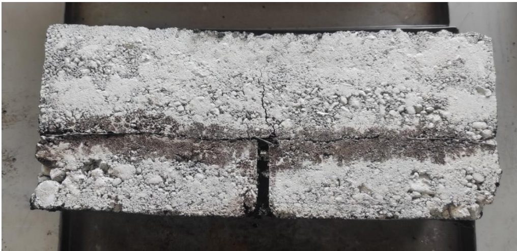
Ilustración 26: Deformación viga B1
