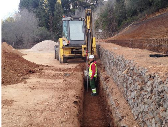
Figura 1. Apertura de zanja
