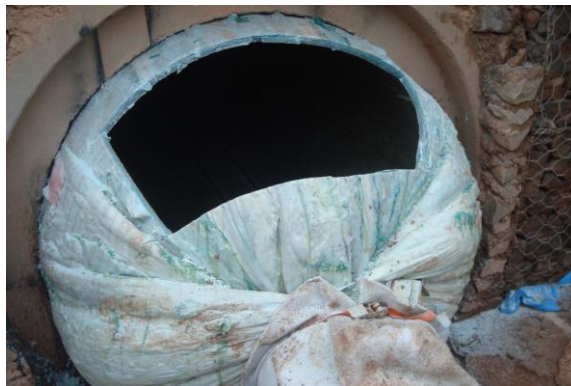
Figura 21. Expansión de la manga en la tubería
