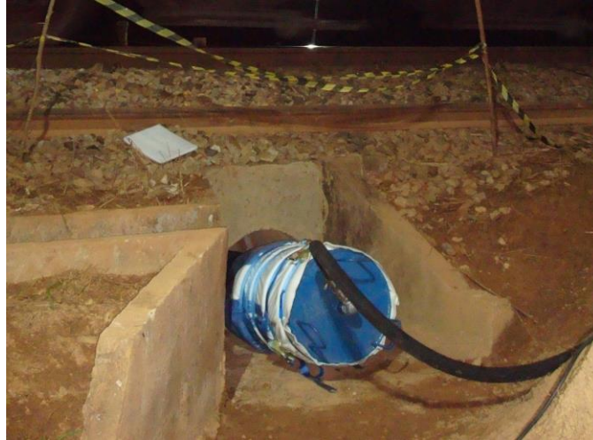
Figura 30. Tubería en proceso de reparación
