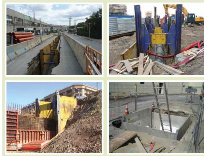
Figura 4. Tipos de zanja
