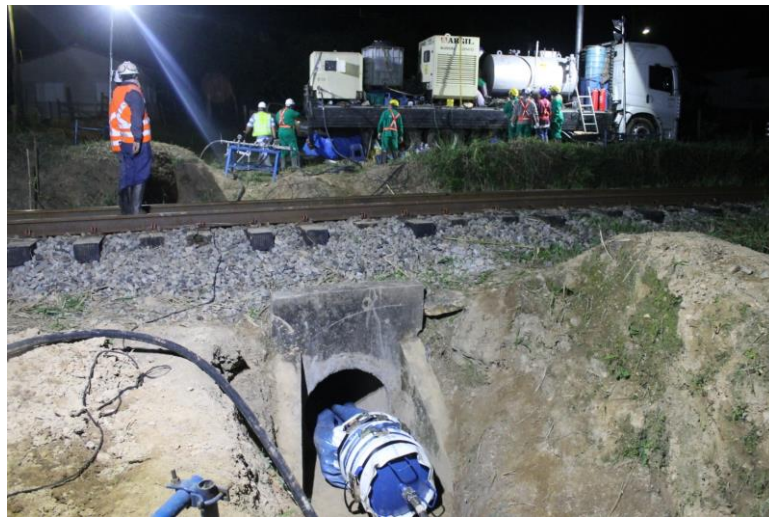
Figura 29. Expansión de la manga mediante presión
