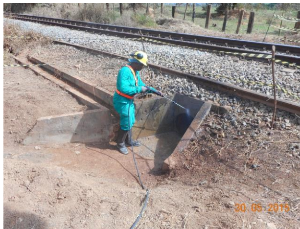
Figura 27. Limpieza de la red de tuberías
