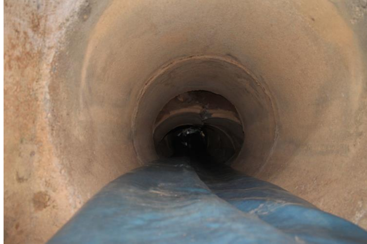
Figura 28. Manga CIPP introducida en la tubería
