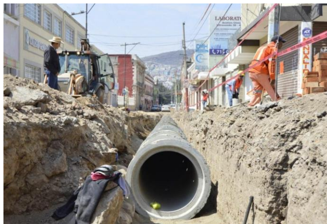
Figura 34. Bloqueo de vía por reparación de tubería con zanja
