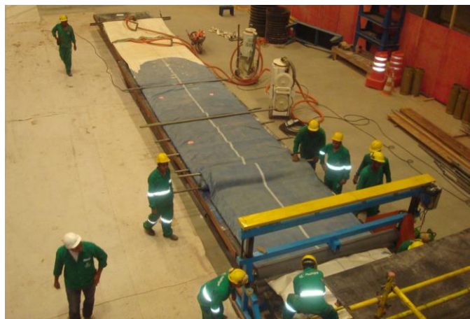
Figura 19. Manga de resina flexible
