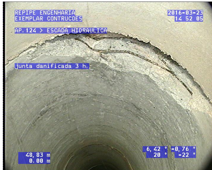
Figura 17. Exploración de tubería (tramo 1)
