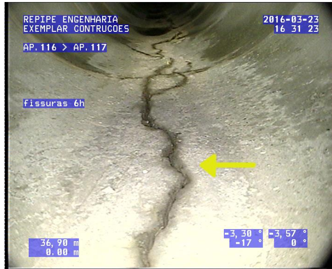
Figura 18. Exploración de tubería (tramo 2)
