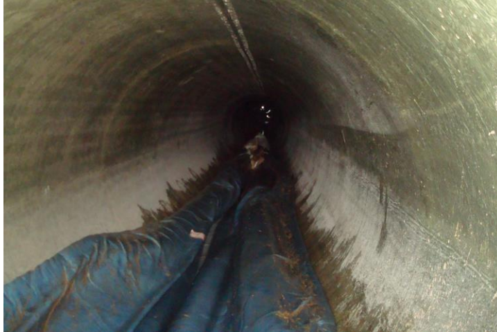
Figura 20. Extensión de la manga en la tubería
