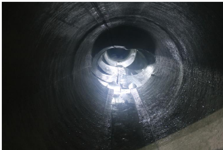
Figura 31. Tubería Rehabilitada mediante CIPP
