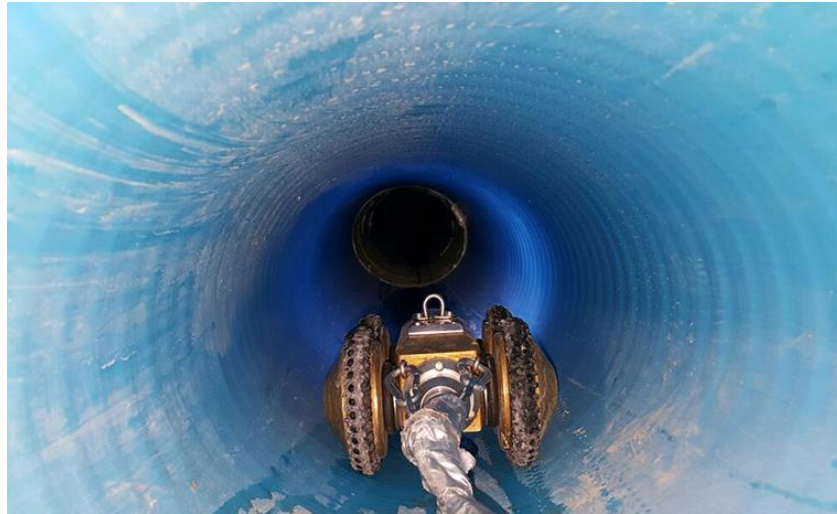
Figura 8. Inspección de tuberías mediante cámaras
