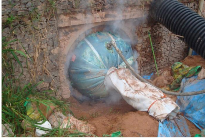
Figura 22. Curado mediante agua caliente y fría
