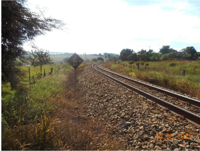
Figura 25. Vía férrea sobre la tubería
