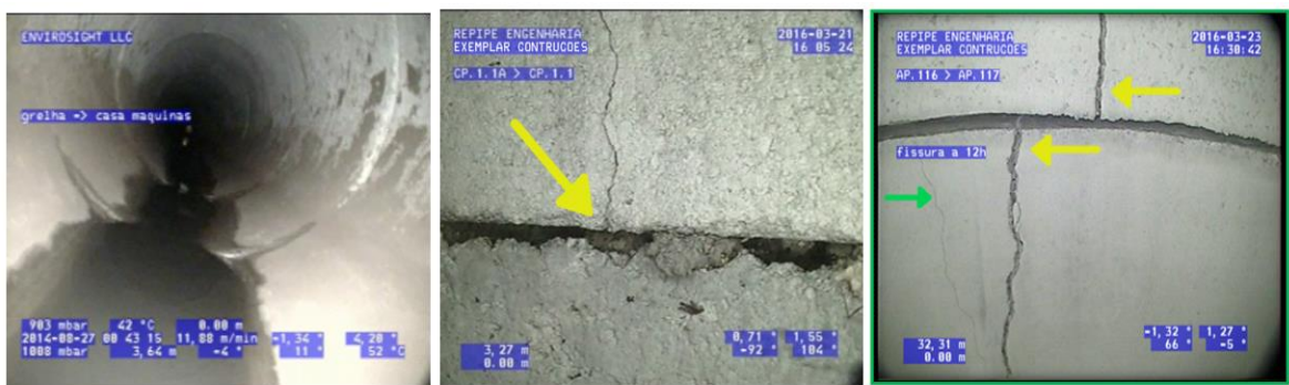
Figura 33. Inspección de tubería mediante CCTV
