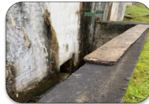
Desagüe del desarenador
