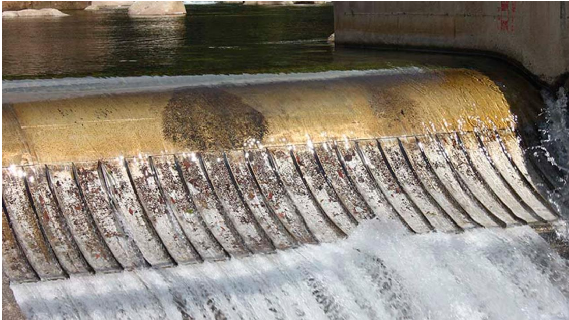
Ilustración 7. Rejilla tipo Coanda
