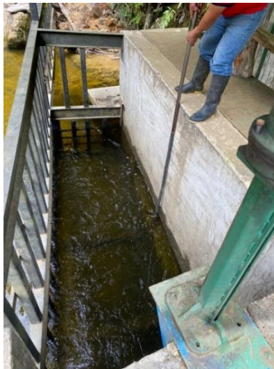
Ilustración 18. Mantenimiento de la rejilla lateral
