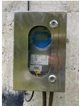
Ilustración 17. Caudalímetro actual de la captación
